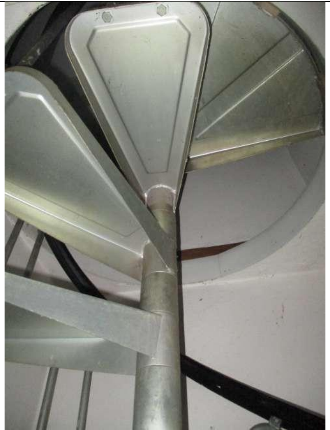
Scala a chiocciola di collegamento tra i due livelli
