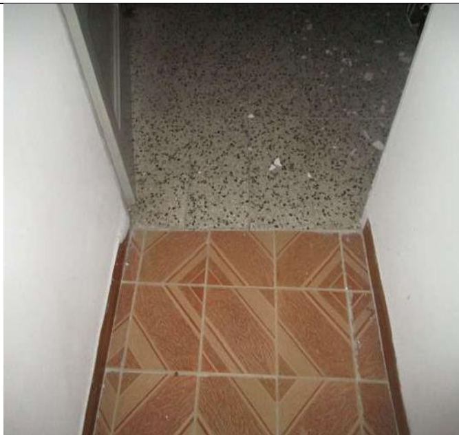
Particolare della pavimentazione piano primo
