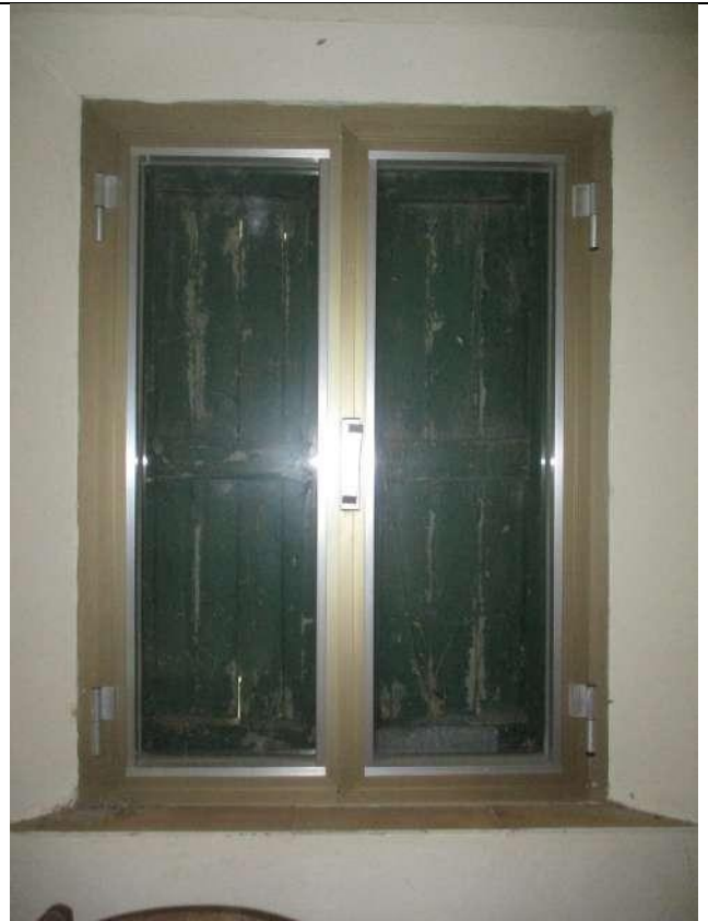
Finestra del piano terreno
