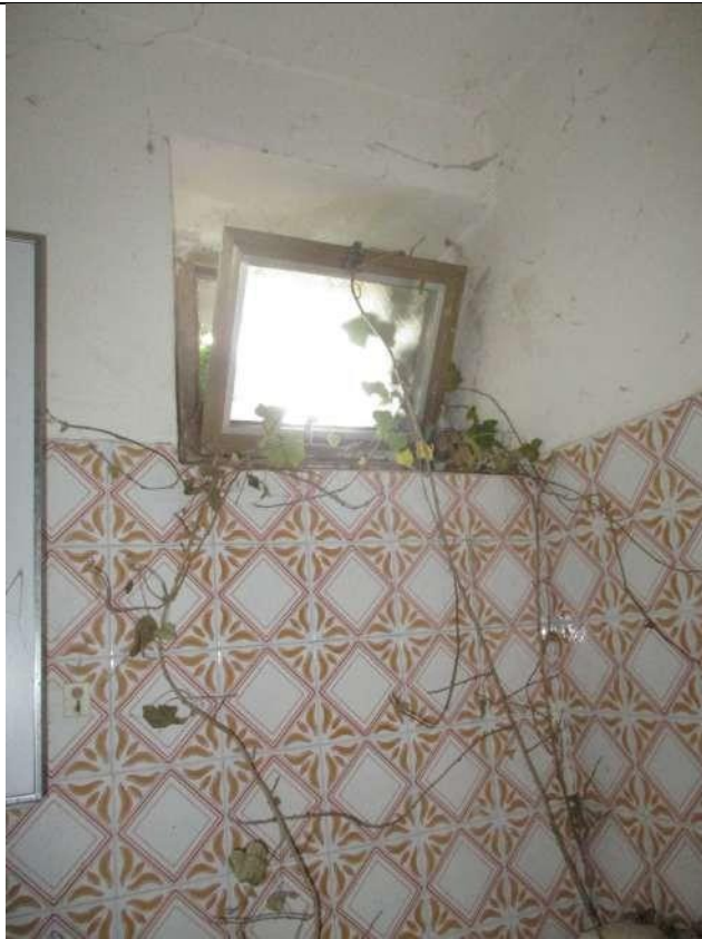
Finestra del Servizio Igienico
