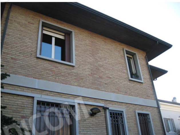
Particolare prospetto e balcone fianco nord
