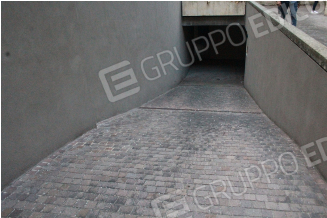
rampa di accesso al piano seminterrato
