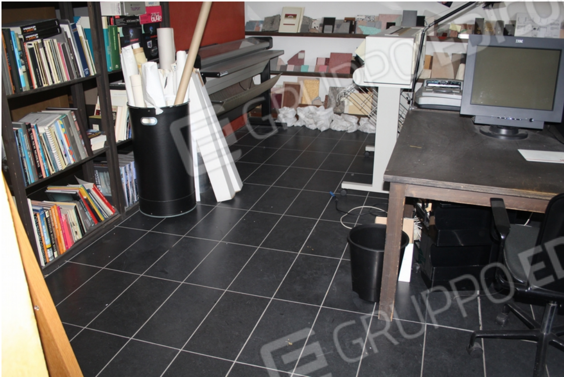
particolare pavimentazione ufficio
