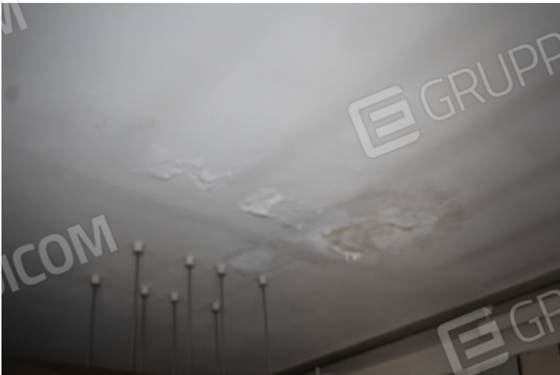
particolare soffitto ufficio
