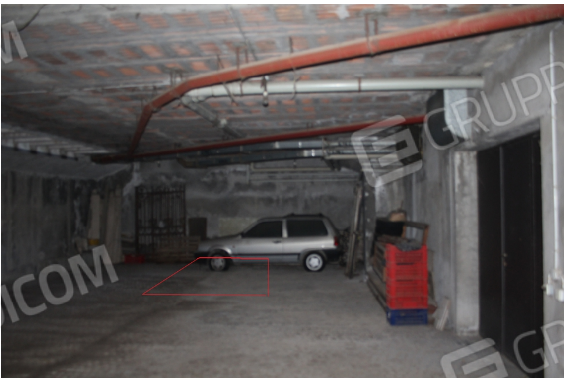
posto auto coperto piano seminterrato
