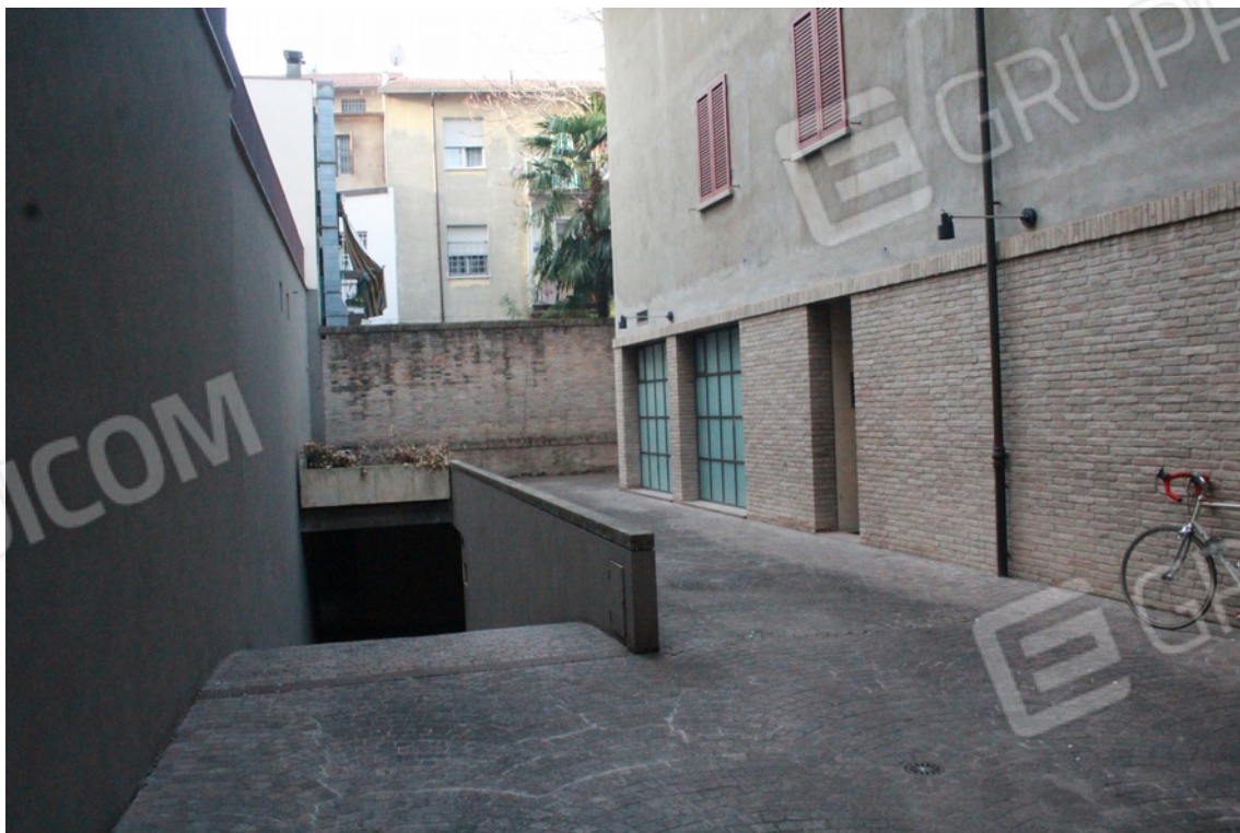
vista esterna rampa di accesso piano seminterrato
