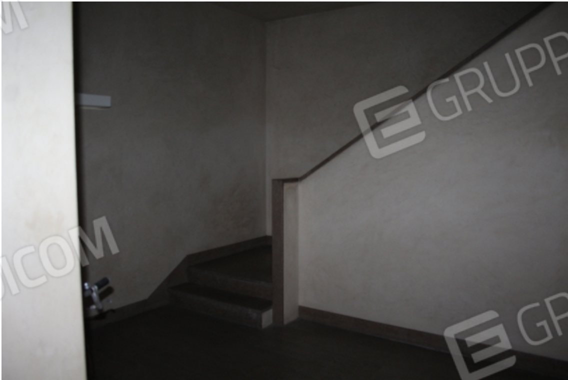
vano scala comune
