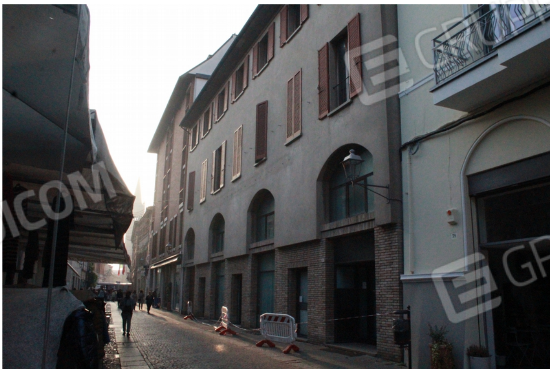
Vista esterna del fabbricato dalla pubblica Via delle Torri
