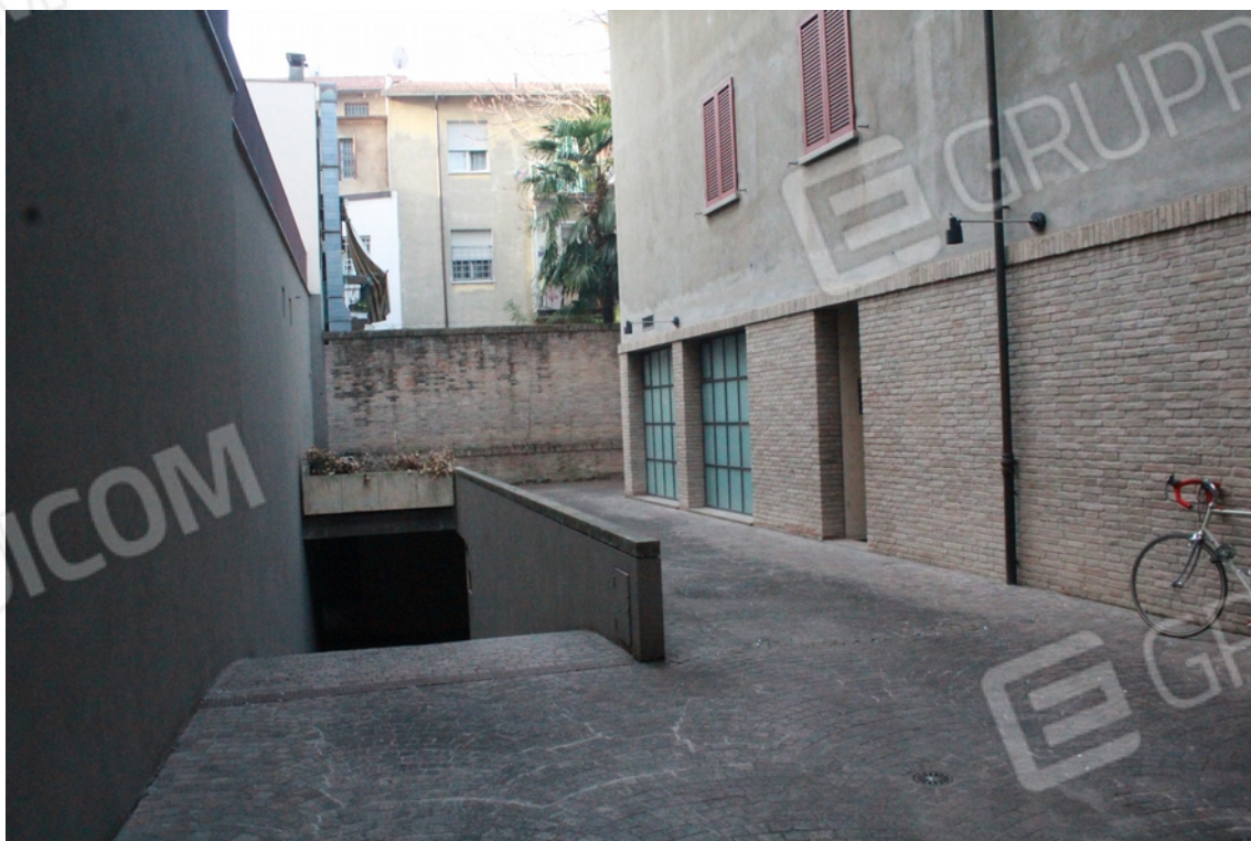
vista esterna rampa di accesso al piano seminterrato
