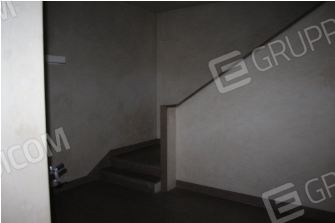
vano scala comune
