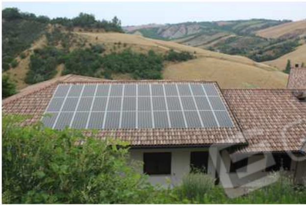
Foto 82: pannelli fotovoltaici in copertura agriturismo
