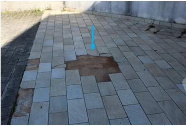
Foto 54 - 55: distacchi nelle pavimentazioni esterne prossime all'edificio
