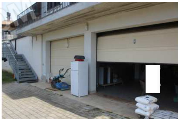
Foto 78: ingresso al deposito garage
