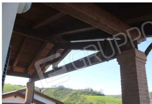
Foto 40 - 41: terrazzo al piano primo e dettaglio della capriata a vista sul prospetto nord
