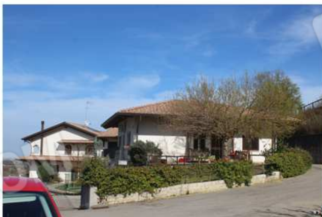
Foto 2: il complesso visto dal lato opposto all'ingresso
