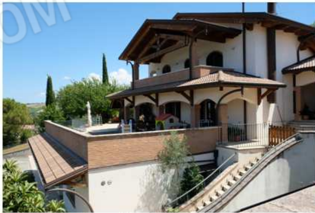
Foto 28: portico anteriore al piano terra
