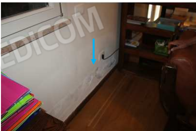
Foto 50 - 51: degrado da umidità alle pareti del soggiorno
