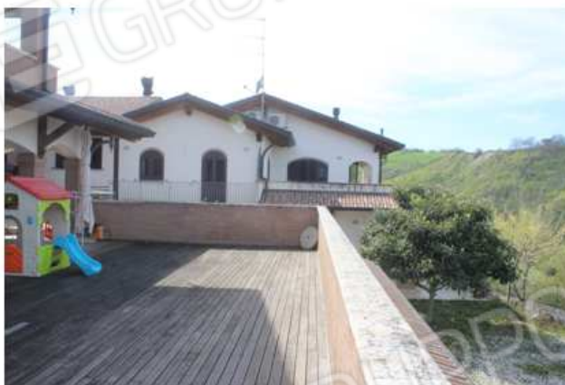
Foto 3: vista sui fabbricati in sequenza
