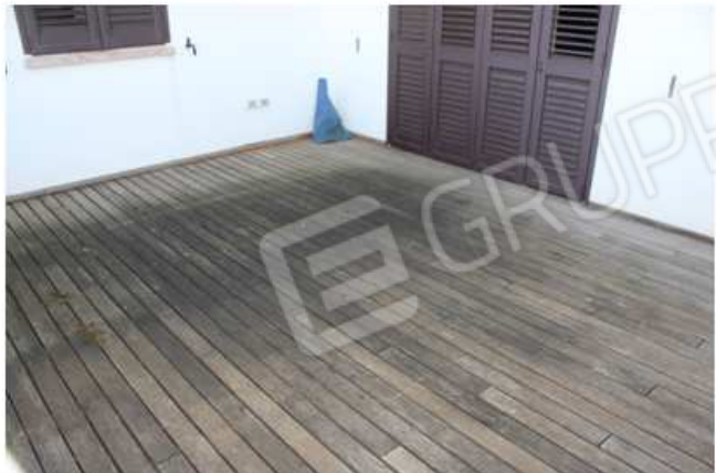
Foto 73 - 74: loggia e terrazzo
