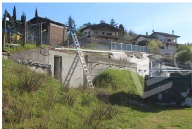
Foto 121: vista sul manufatto tecnico
