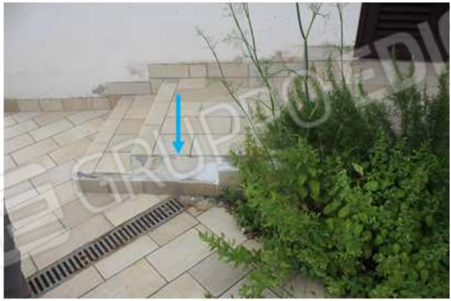
Foto 54 - 55: distacchi nelle pavimentazioni esterne prossime all'edificio
