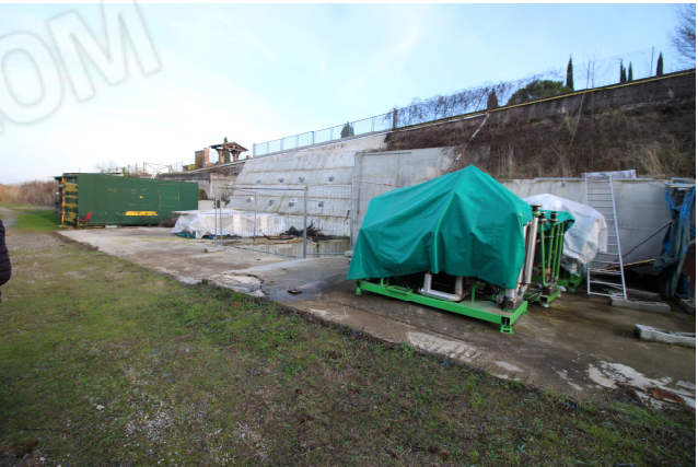
Foto 135: vista sull'area e macchinari ancora non rimossi
