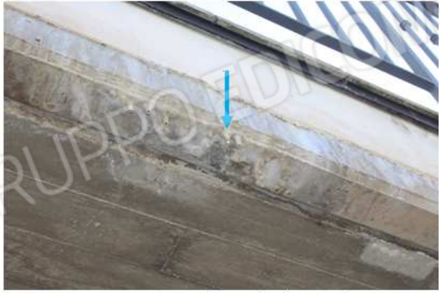
Foto 53: stalattiti di sottofondo percolato
