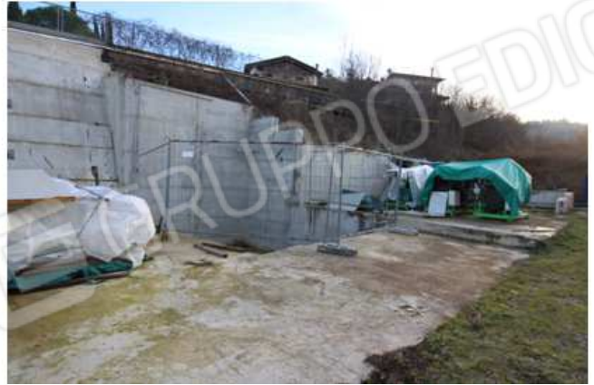
Foto 133-134: opere di sostegno e solette pavimentanti in cemento armato ancora presenti sul posto.
