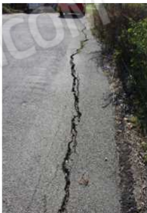
Foto 12-13: lesioni sulla carreggiata subparallele alle linee di equivello del versante
