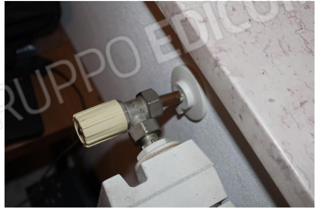
PARTICOLARE TUBAZIONE IN RAME DELL'IMPIANTO DI RISCALDAMENTO E TERMOSIFONE PRIVO DI VALVOLA TERMOSTATICA
