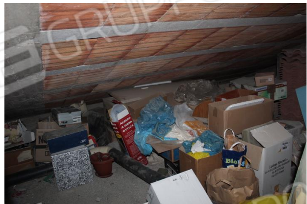
SOTTOTETTO AL GREZZO
