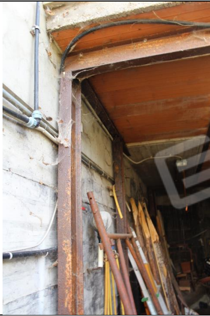
PARTICOLARE STRUTTURA PORTANTE IN FERRO
