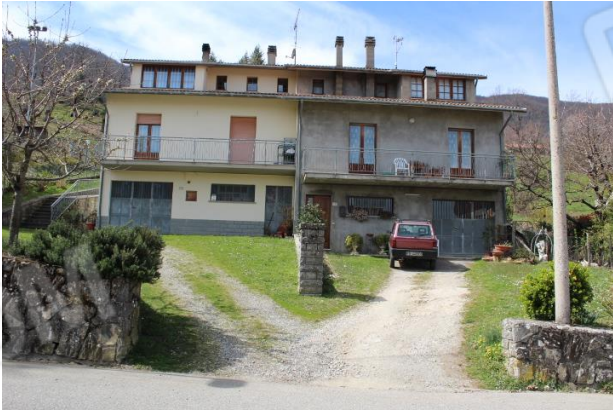
PROSPETTO FRONTE STRADA (est). LA PORZIONE DI BIFAMILIARE OGGETTO DI STIMA E' QUELLA POSTA SUL LATO DESTRO, NON TINTEGGIATA
