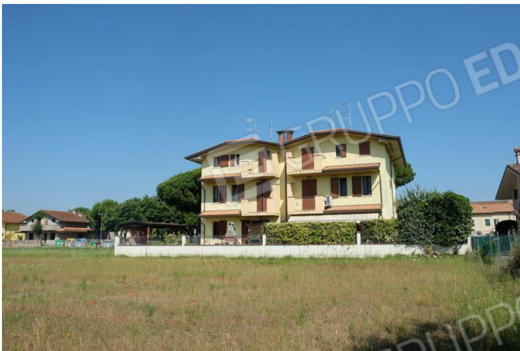
Foto n.4 - veduta dell'intero fabbricato lato Sud-Est
