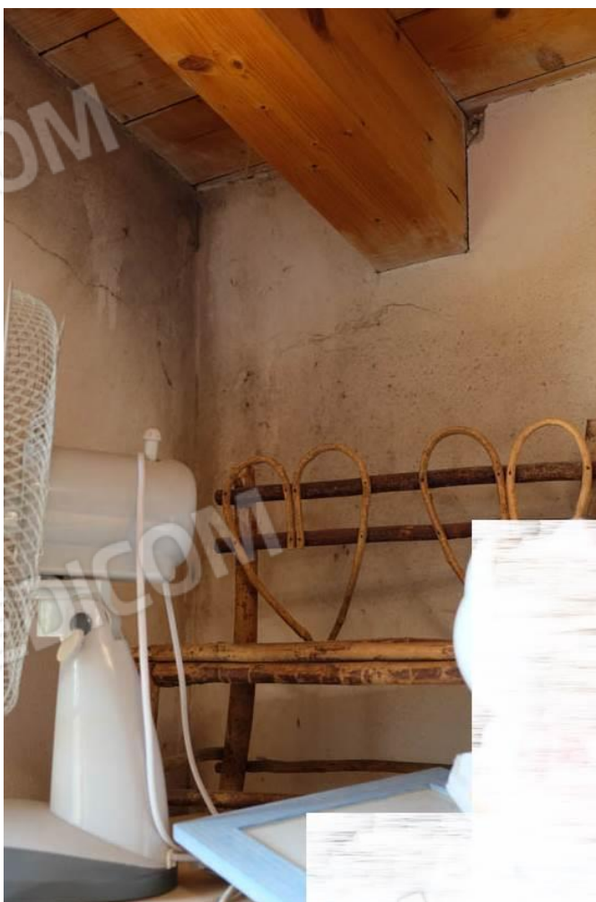
Foto n.64 – particolare parete Ovest del vano servizio con manifestazione di “muffa” al piano secondo (sottotetto)
