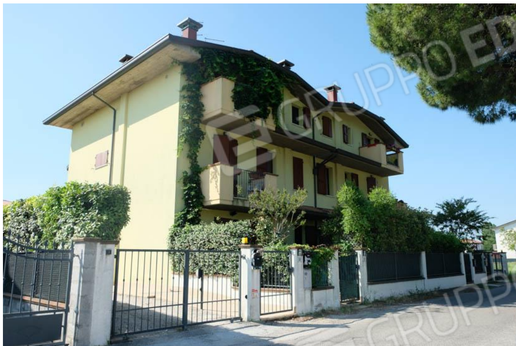
Foto n.2 – veduta dell'intero fabbricato lato Est (lato mare)
