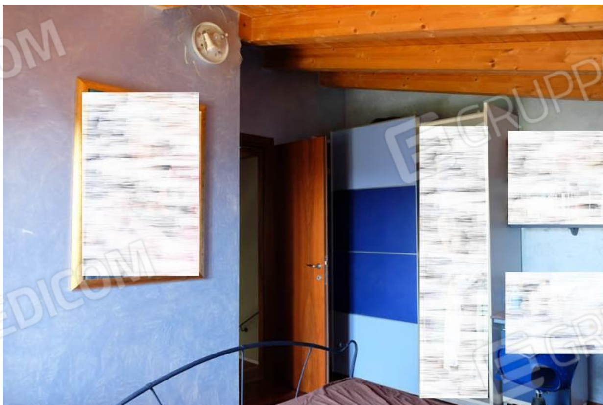
Foto n.39 – veduta locale di servizio, utilizzato come camera, posto al piano secondo (sottotetto)
