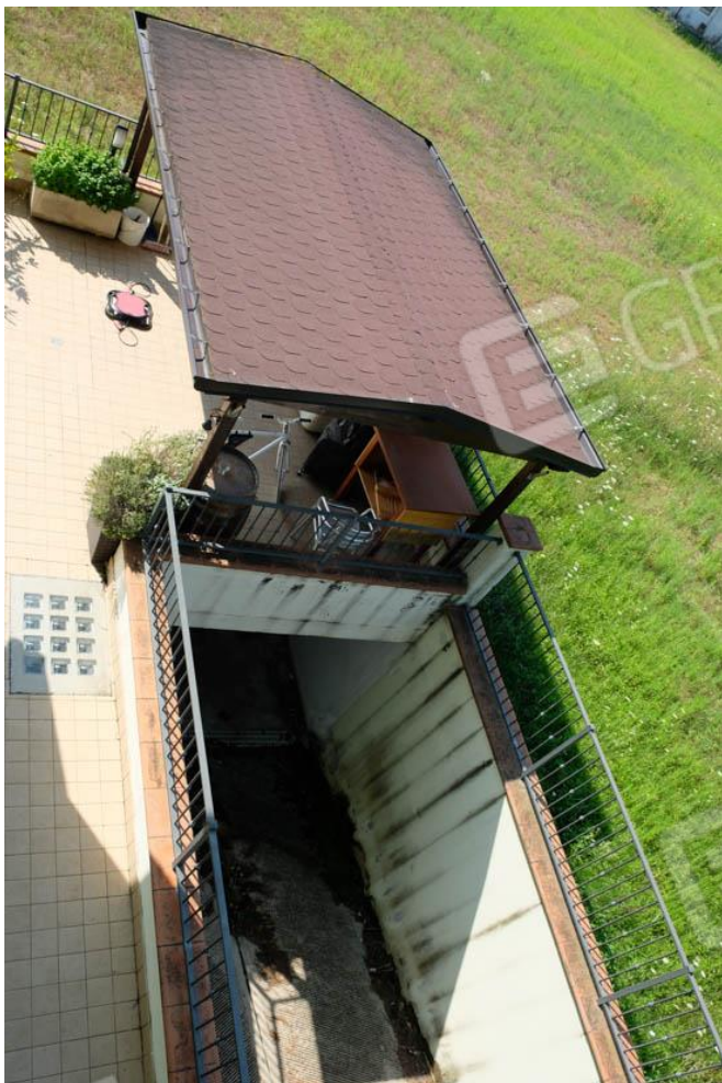
Foto n.12 – veduta, dalla finestra della scala interna, della tettoia e del cortile di proprietà
