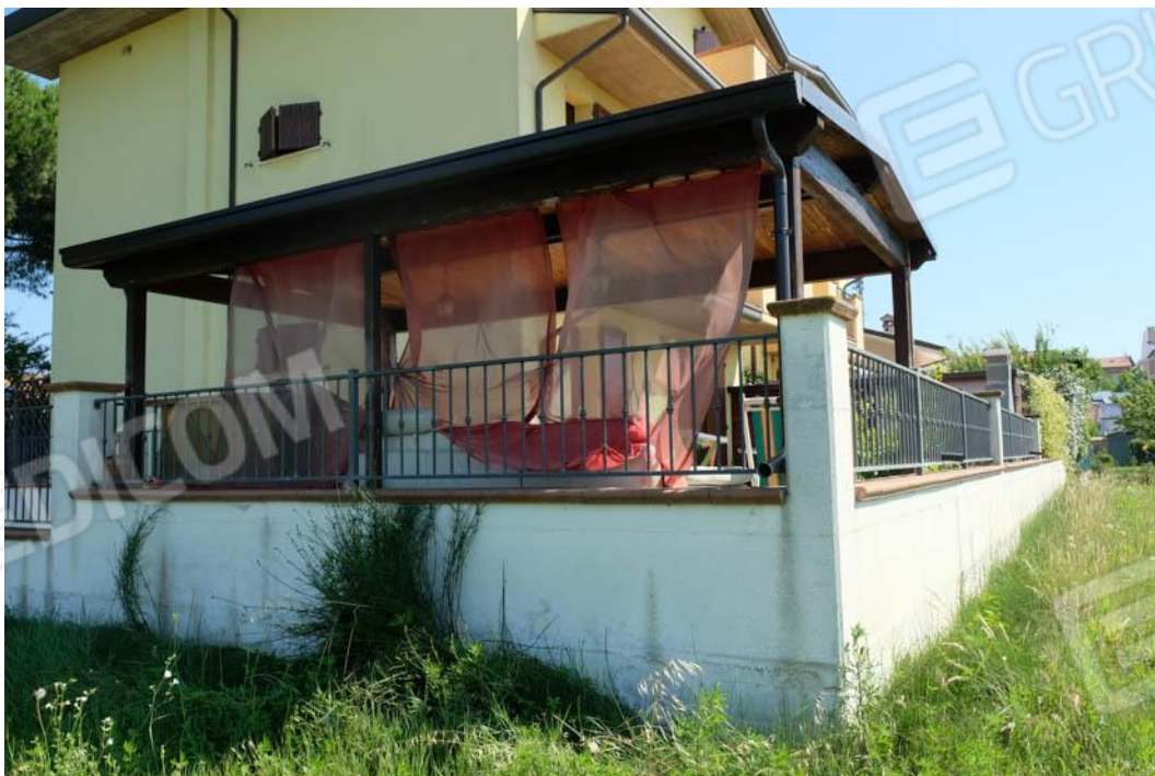
Foto n.13 – veduta della tettoia dal lotto confinante e particolare recinzione esterna
