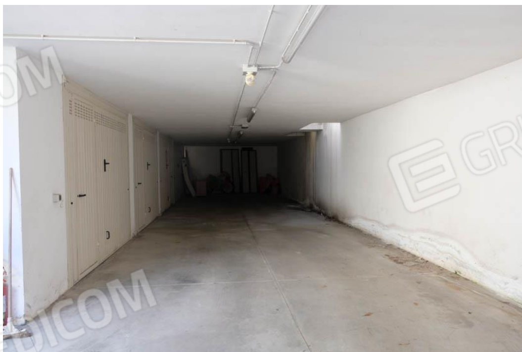
Foto n.89 – veduta dell'area di manovra ad uso comune alle autorimesse poste al piano interrato
