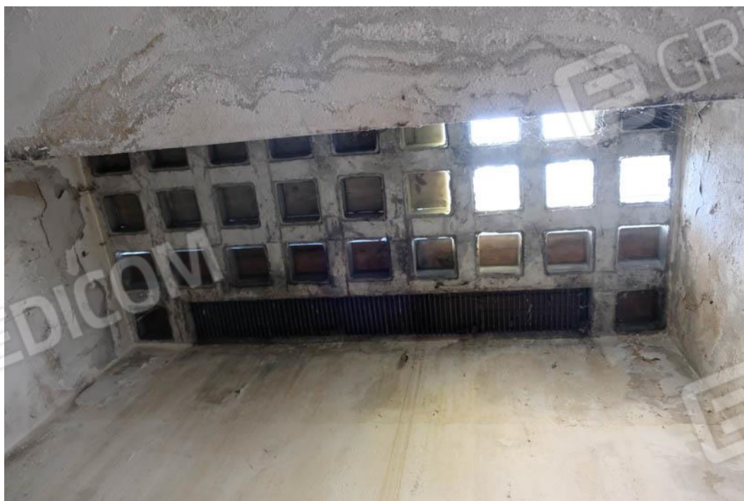
Foto n.95– particolare veduta lucernaio/bocca di lupo presenti nell'area di manovra dell'accesso alle autorimesse poste al piano interrato, e nelle corti delle singole u.i.
