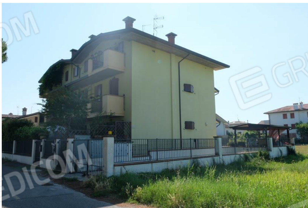
Foto n.3 - veduta dell'intero fabbricato lato Ovest (lato monte)
