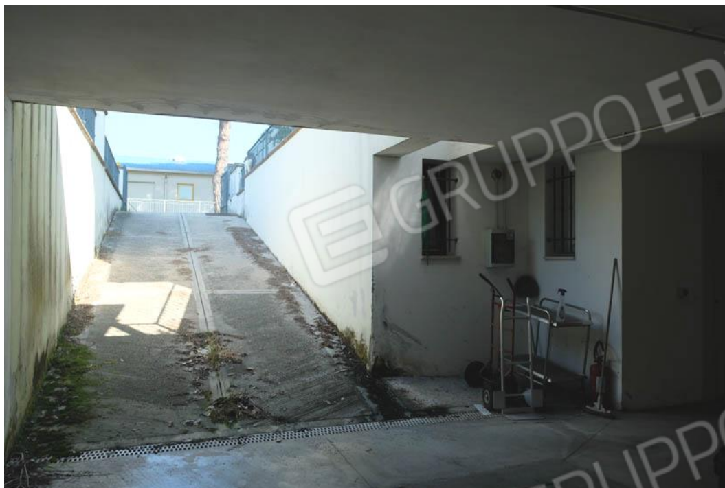
Foto n.90 – veduta dell'accesso e dell'area di manovra ad uso comune alle autorimesse poste al piano interrato
