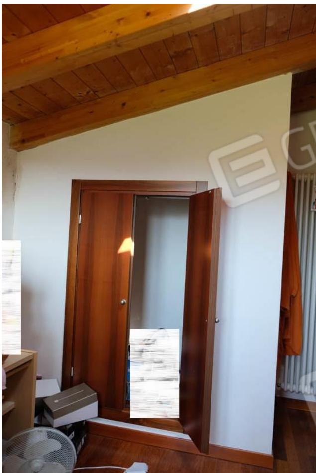
Foto n.58 – veduta locale di servizio posto al piano secondo (sottotetto)
