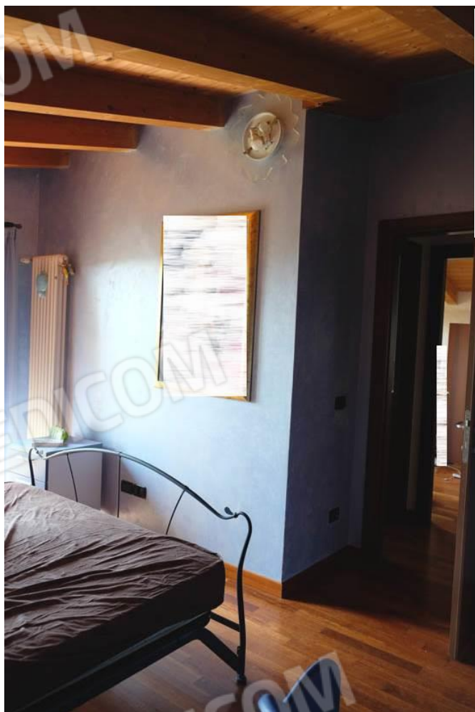
Foto n.37 – veduta locale di servizio, utilizzato come camera, posto al piano secondo (sottotetto)
