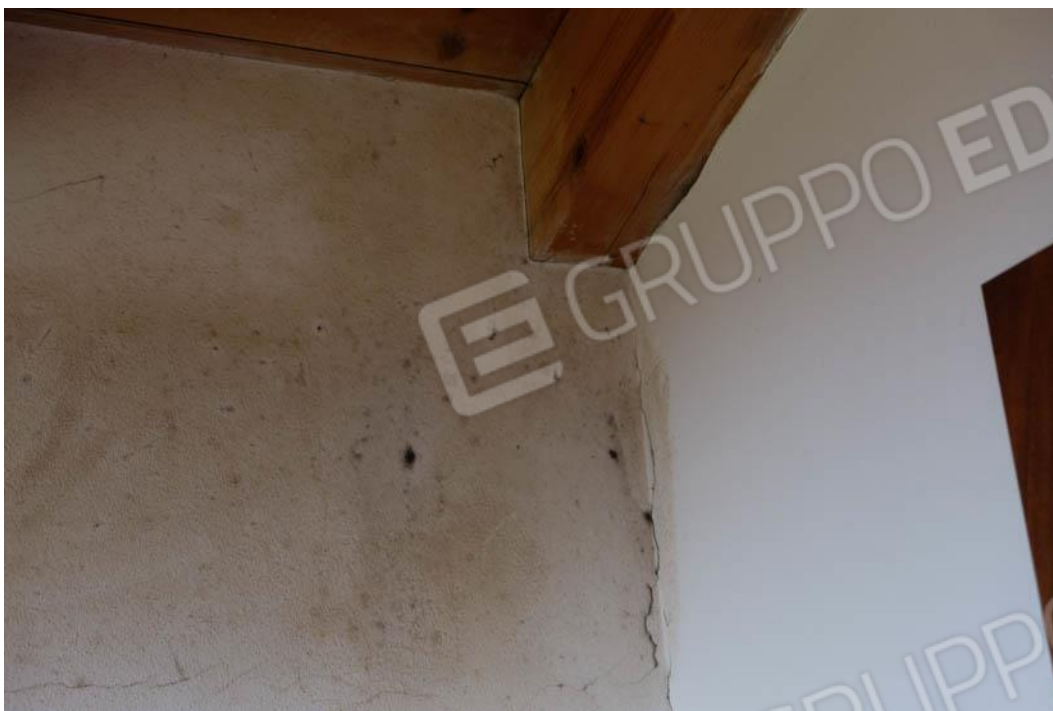
Foto n.64 – particolare parete Ovest del vano servizio con manifestazione di “muffa” al piano secondo (sottotetto)
