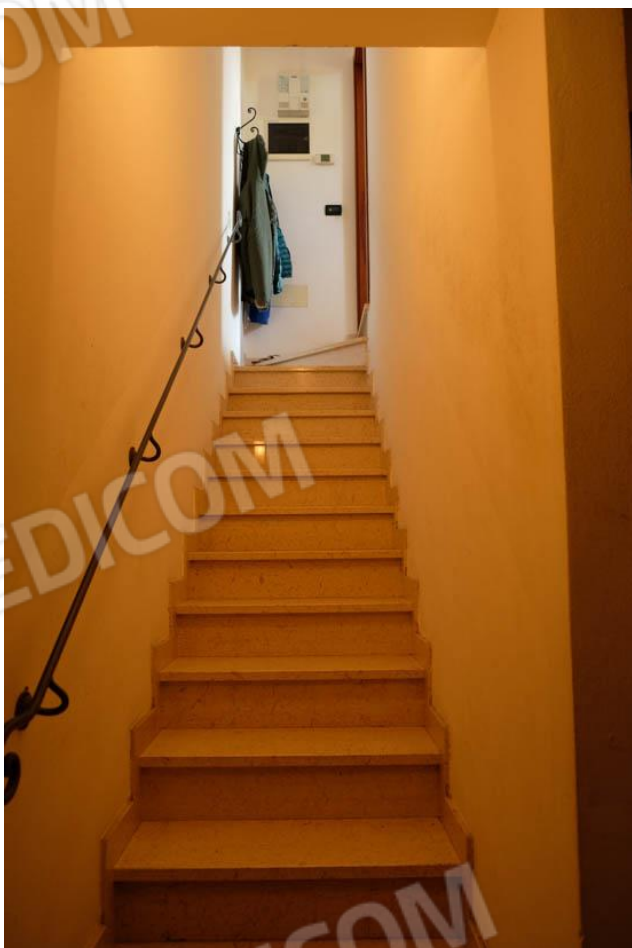
Foto n.67 – veduta scala di collegamento dal piano interrato al piano terra
