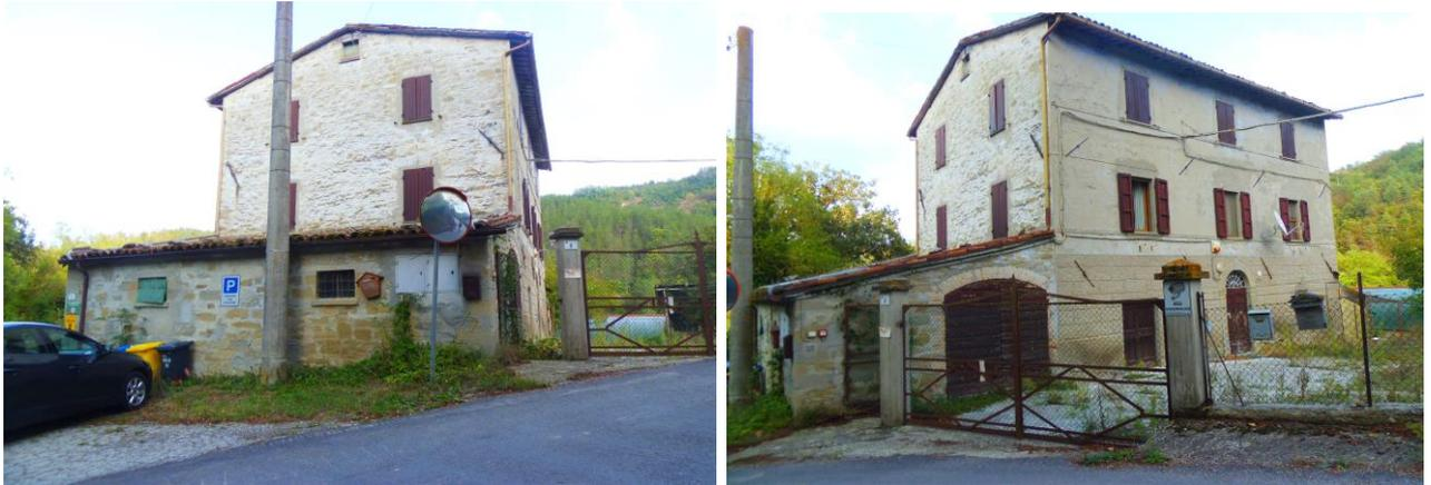
Gli infissi esterni sono in legno con vetro semplice, dotati di scuroni esterni in legno verniciato. Porte interne in legno. Pavimentazione mista, prevalente in cotto e ceramica e graniglia. Soffitti con travi e tavelle a vista, in parte anche verniciate.
