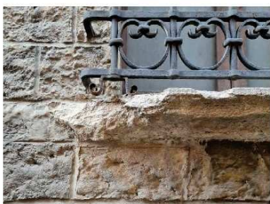
FOTO 94 - FACCIATA PRINCIPALE BANCHINA FINESTRE
