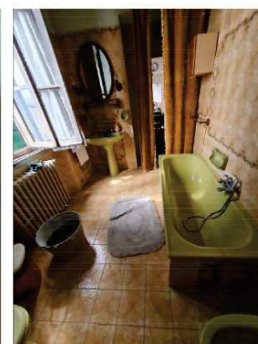
FOTO 61 - PIANO SECONDO BAGNO
