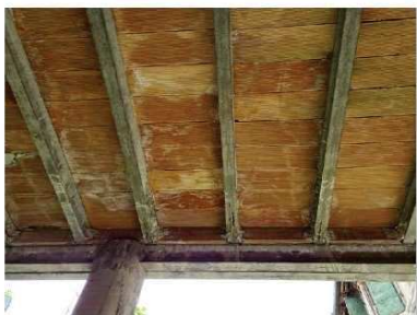
FOTO 33 - PIANO INTERRATO COPERTURA PORTICO
