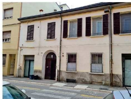
B - via Chiaramonti n°65 FACCIATA SU VIA CHIARAMONTI
