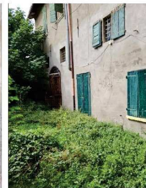
FOTO 32 - PIANO INTERRATO ALA A SERVIZI
