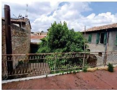
FOTO 92 - VISTA CANNA FUMARIA CENTRALE TERMICA
