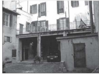
FOTO STORICA - TERRAZZO, PORTICO, CORTILE E CENTRALE TERMICA
