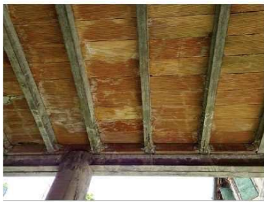
FOTO 33 - PIANO INTERRATO COPERTURA PORTICO
