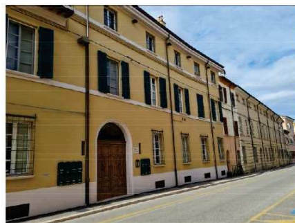
C - via Chiamonti n°75 FACCIATA SU VIA CHIARAMONTI
