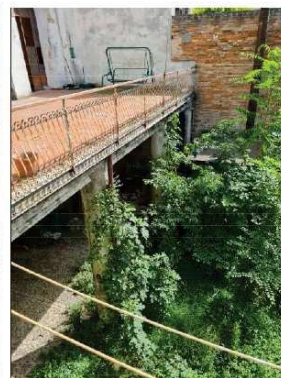
FOTO 14 - TERRAZZO E PORTICO INTERRATO
