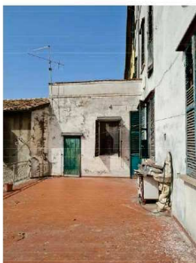
FOTO 11 - TERRAZZO CON VISTA ALA SERVIZI
