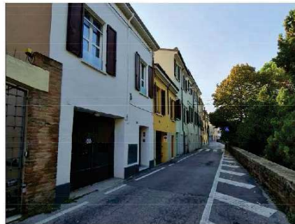
D - FACCIATA SU VIA MURA COMANDINI
