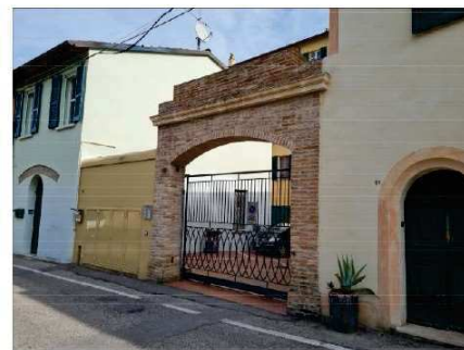
C - via Mura Comandini n°49 FACCIATA SU VIA MURA COMANDINI
