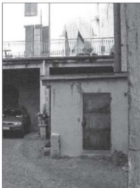
FOTO STORICA - CENTRALE TERMICA
