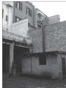
FOTO STORICA - CENTRALE TERMICA
