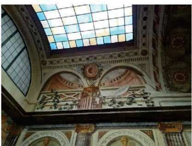
FOTO 28 - COPERTURA VANO SCALA
