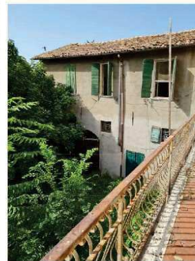
FOTO 7 - VISTA DEL FABBRICATO A SERVIZI
