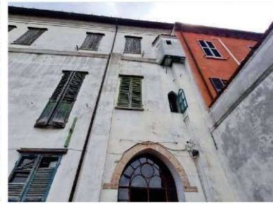
FOTO 3 - VISTA DA VIA MURA FEDERICO COMANDINI
