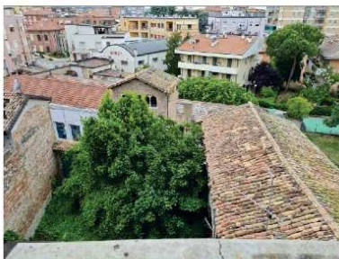
FOTO 9 - VISTA DALL'ALTO DEL CORTILE INTERNO
