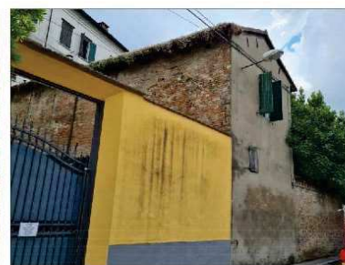
FOTO 10 - FABBRICATO A SERVIZI DA VIA MURA FEDERICO COMANDINI
