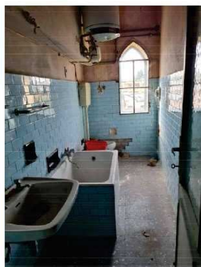
FOTO 46 - PIANO PRIMO BAGNO
