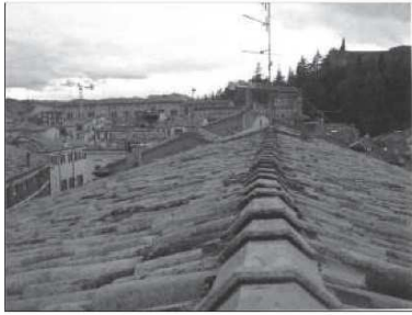
FOTO STORICA - VISTA COPERTURA
