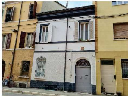
D - via Chiamonti n°55 FACCIATA SU VIA CHIARAMONTI
