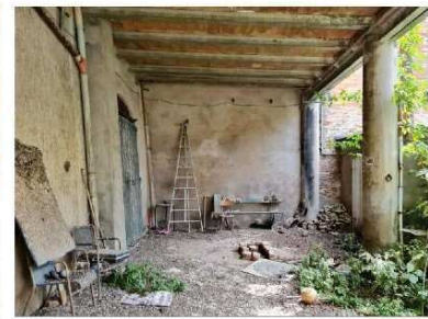
FOTO 35 - PIANO INTERRATO PORTICO
