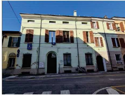
A - via Chiamamonti n°47 FACCIATA SU VIA CHIARAMONTI
