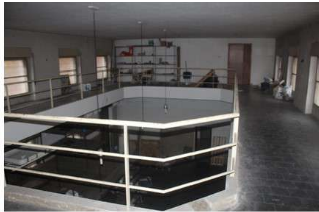
Foto 17: ballatoio al piano primo - vista da scala
