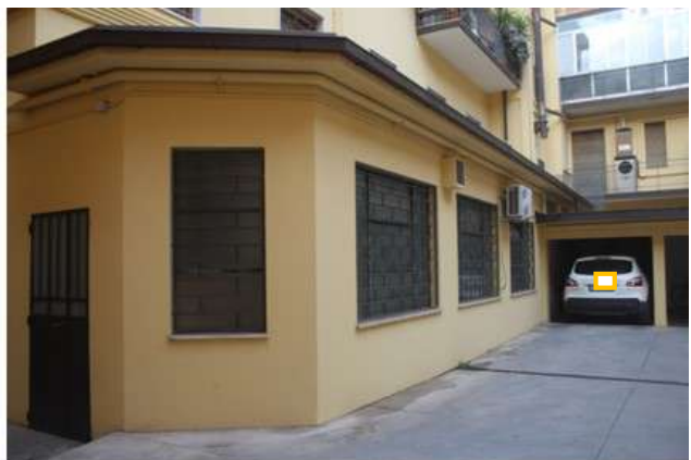
Foto 4: prospetto unità pignorata verso la corte interna
