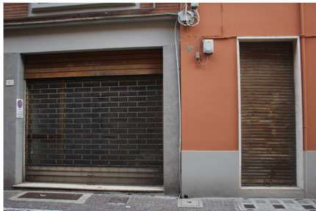
Foto 5: accessi da via Albicini civico 1A
