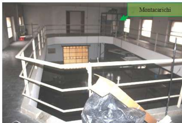
Foto 18: ballatoio al piano primo - vista verso la scala
