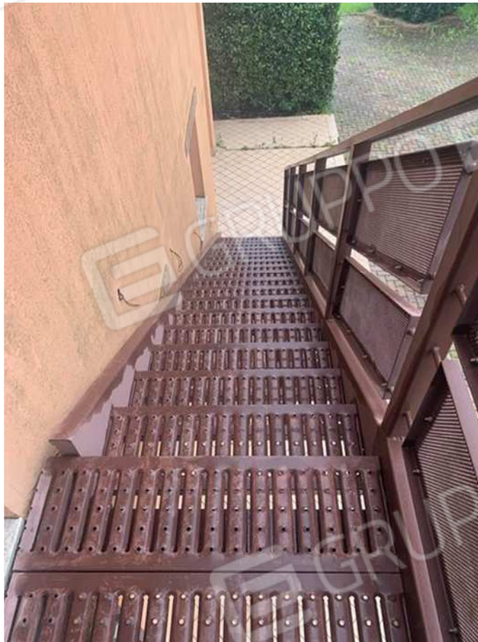
Scala esterna accesso sottotetto
