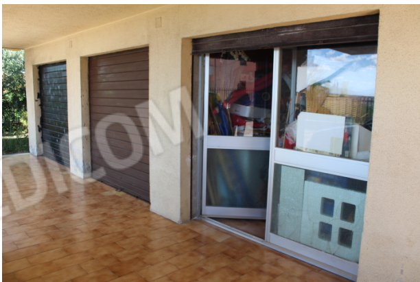
PORTICO VISTO VERSO OVEST; CON LA SERRANDA ALZATA L'AUTORIMESSA OGGETTO DI STIMA
