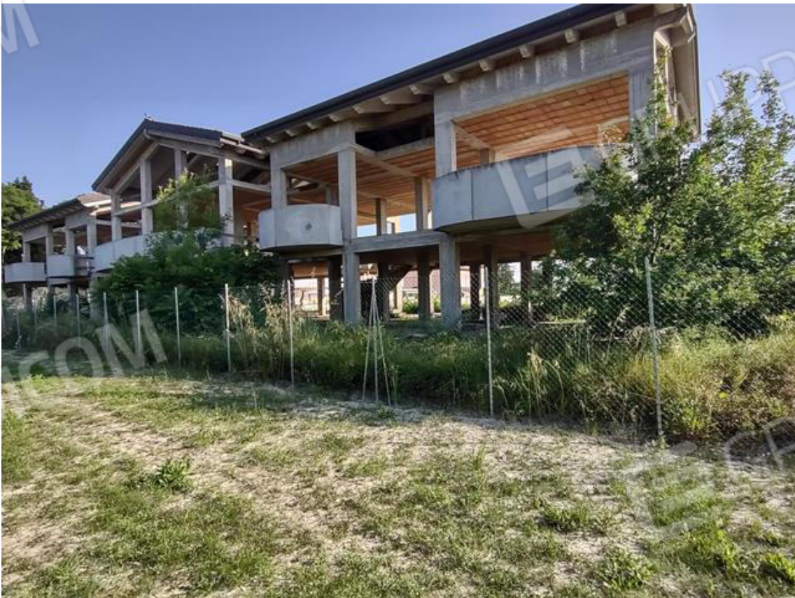
FOTO 4. Fabbricato in costruzione: prospetto Nord-Est
