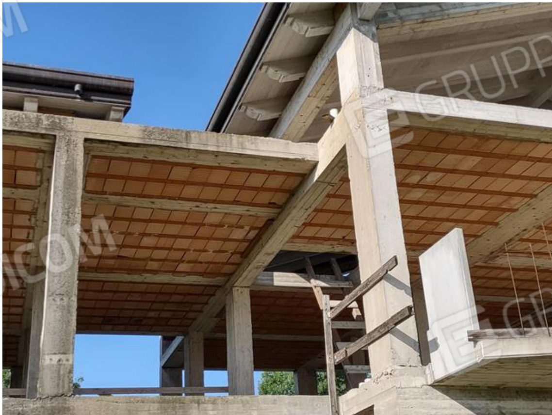
FOTO 6. Fabbricato in costruzione: particolare del piano primo con asola per scala interna
