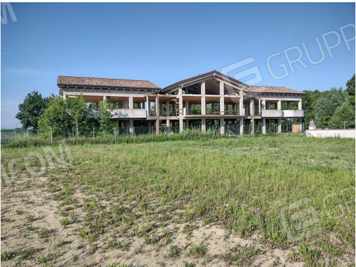
FOTO 2. Fabbricato in costruzione: fronte Nord-Est.
