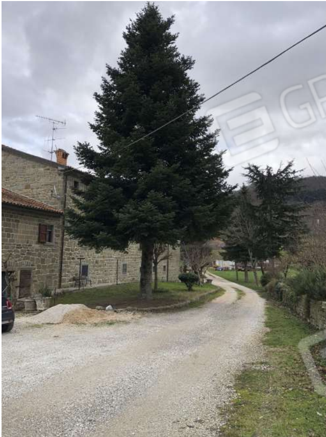
Foto 1- P.IIa 256 - area esterna e viabilità interna
