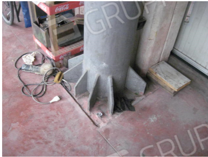
fronte nord con telo in pvc e piede pilastro in metallo a sezione circolare della pensilina
