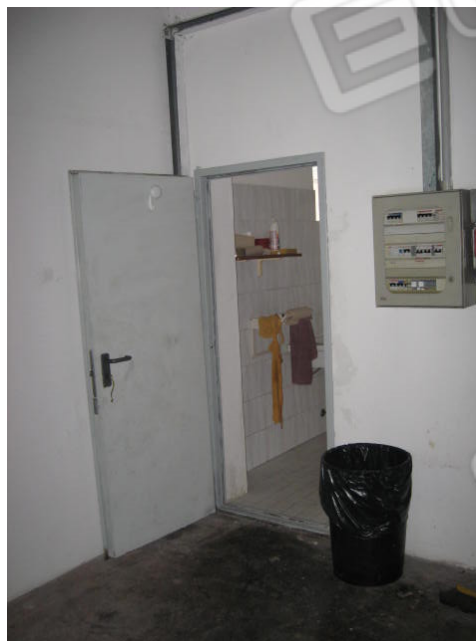
porzione fronte nord ed
