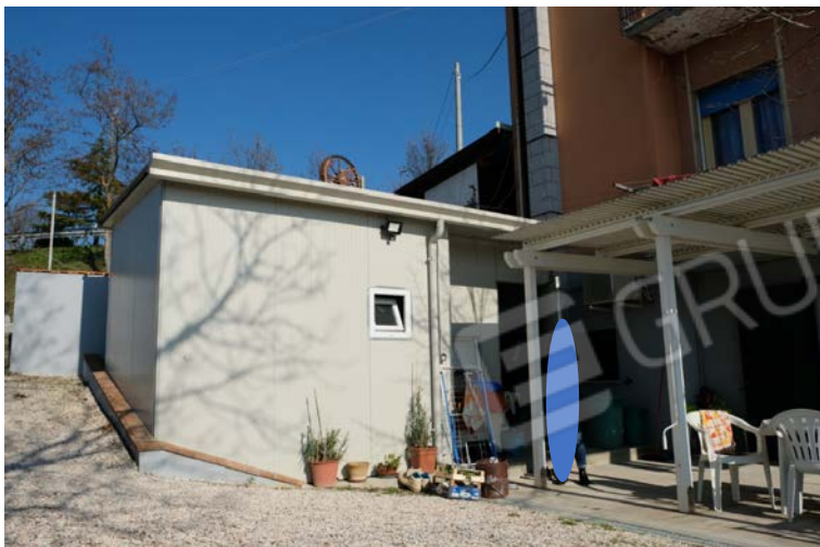
foto n.93 – veduta esterna del ripostiglio censito come b.c.n.c ai sub.7 e 11, oggetto della pretese procedura
