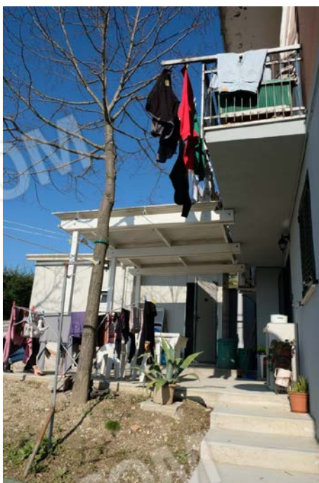
foto n.11 - veduta del ripostiglio identificato con il sub.9 (bene comune non censibile)
