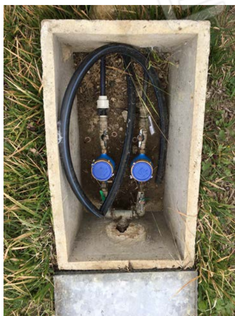
foto n.122-123 – veduta del pozzetto e dei contatori dell'acqua
