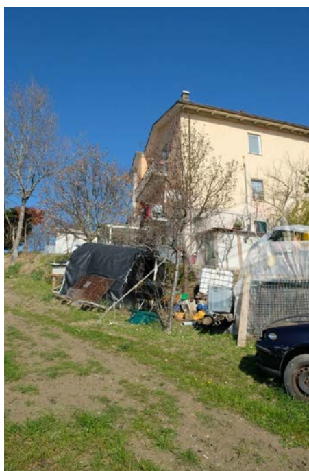
foto n.8 - veduta di parte dell'intero fabbricato in cui sono ubicate le u.i. oggetto di procedura (retro e fianco lato particella 139)
