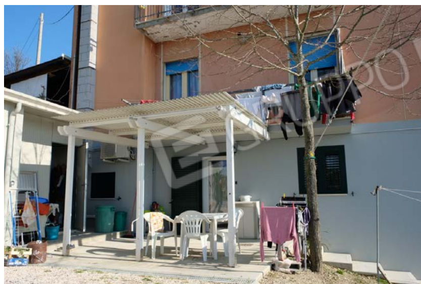
foto n.12 - veduta di parte del ripostiglio identificato con il sub.9 (bene comune non censibile), della tettoia realizzata senza titolo autorizzativo e della porta di accesso all'autorimessa, utilizzata impropriamente come appartamento.
