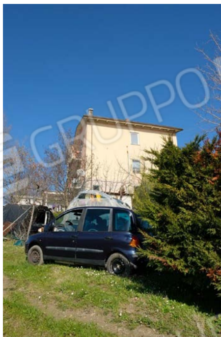
foto n.6 - veduta di parte dell'intero fabbricato in cui sono ubicate le u.i. oggetto di procedura (retro)
