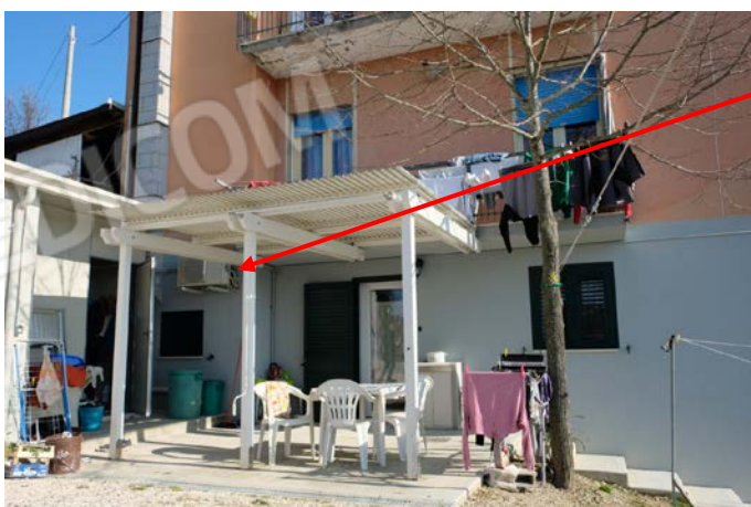
foto n.113 – veduta del corpo esterno dell' impianto di raffrescaemnto degli ambienti adibiti ad appartamento ricavati, senza titolo autorizzativo, nell' autorimessa
