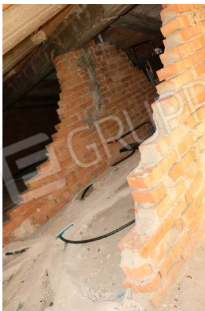
foto n.73-74 – veduta del sottotetto
