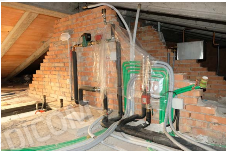
foto n.72 – veduta del sottotetto
