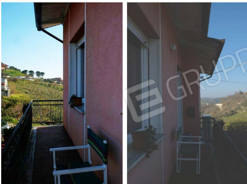
foto n.28-29 – veduta del balcone con accesso dal corridoio, lato porta di ingresso
