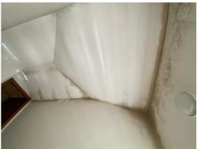
E' stata riscontrata condensa da umidità nell'intradosso del solaio del vano scale.
