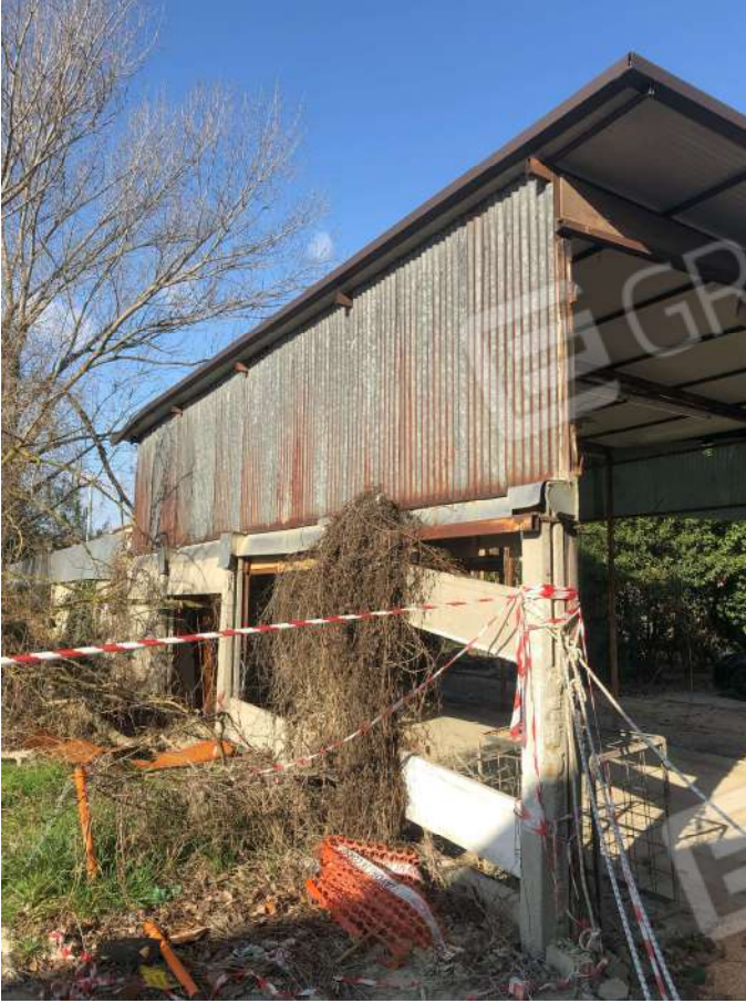
Foto 27- Piano S1/ TERRA -Sub.17 Deposito
