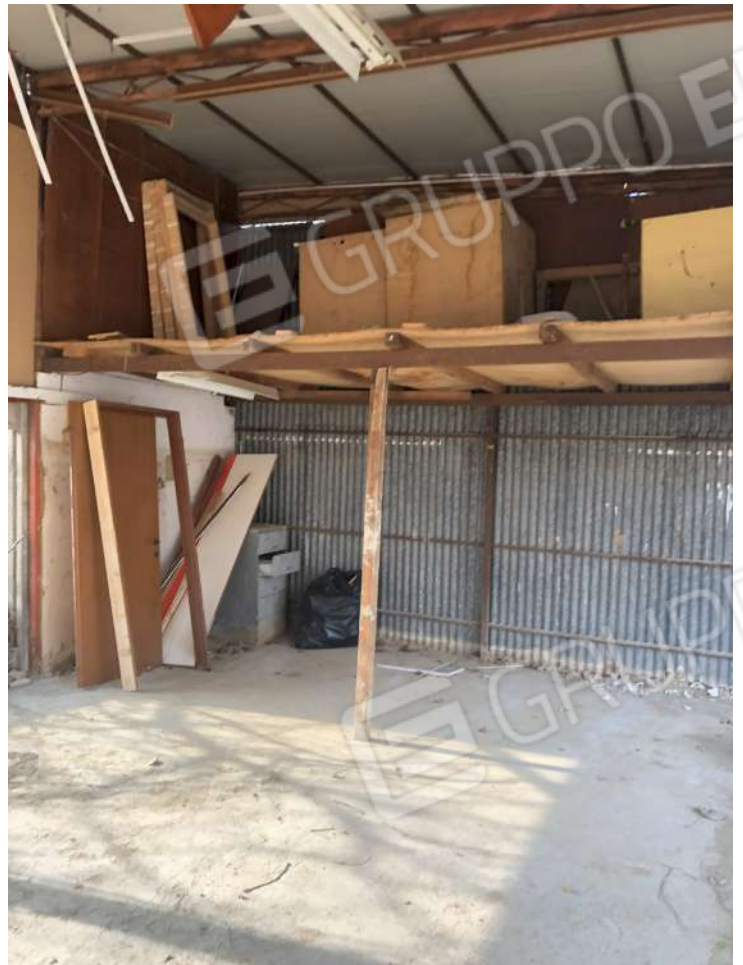
Foto 28- Piano S1/ TERRA -Sub.17 Deposito
