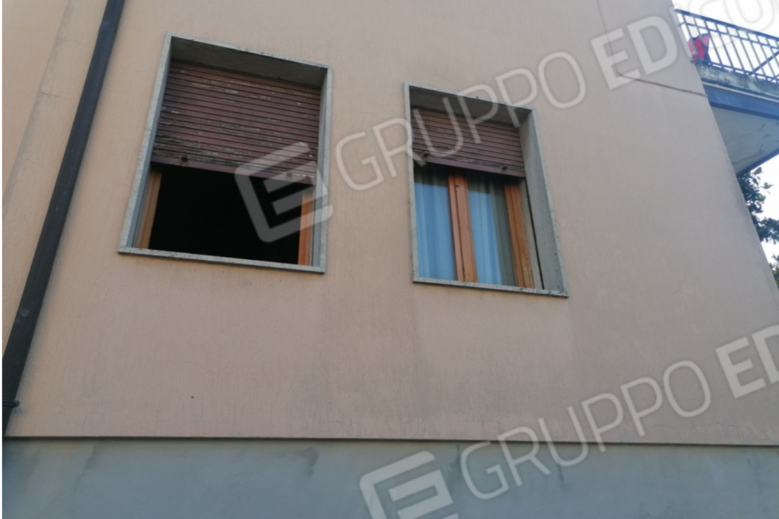
vista esterna del fabbricato sul fianco
