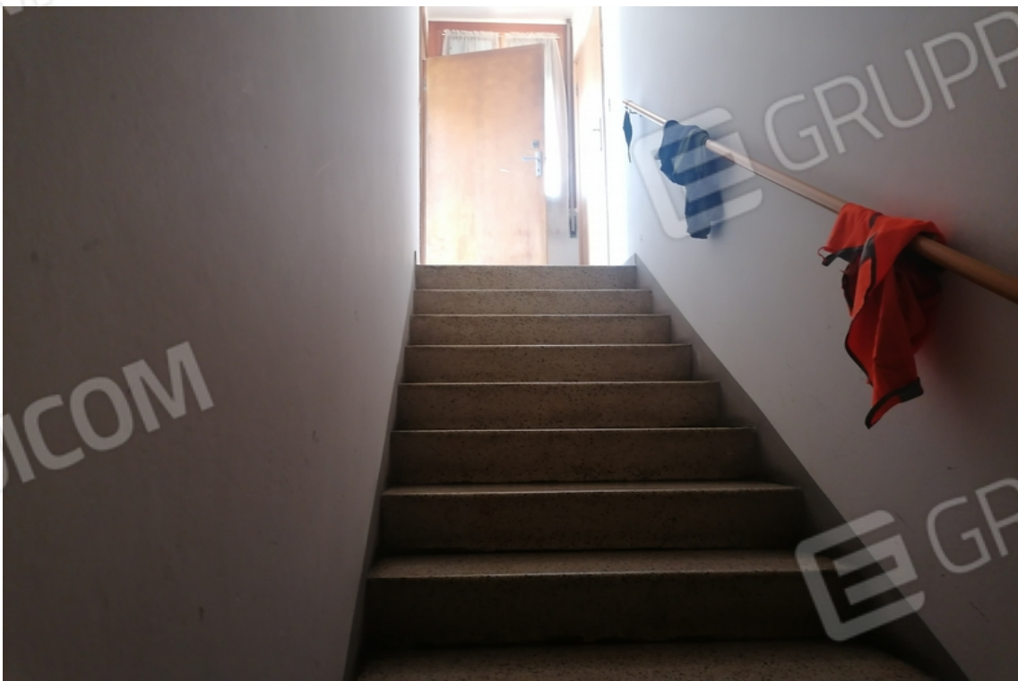
scala di accesso piano seminterrato
