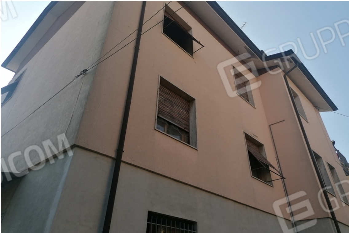
vista esterna del fabbricato sul fianco
