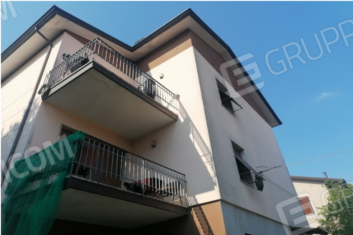
vista esterna del fabbricato sul retro
