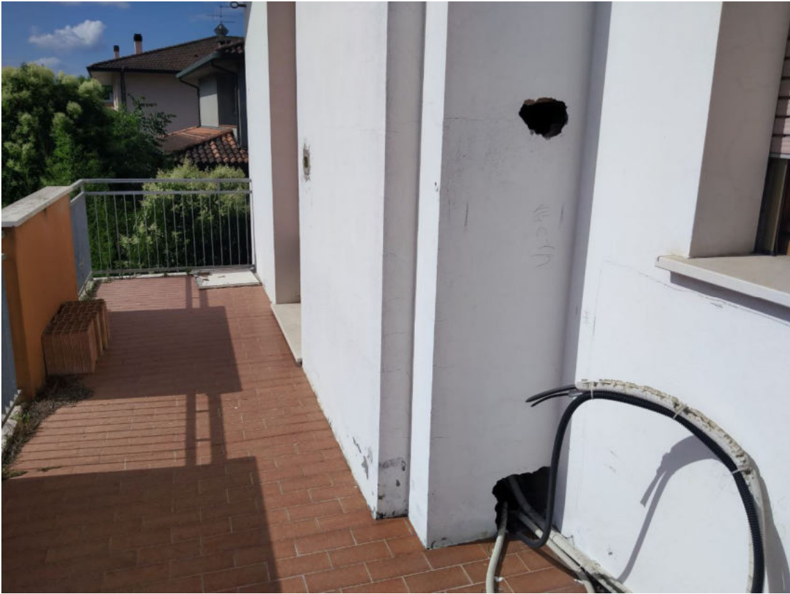
Fot. 12 – Vista esterna dei balconi.
