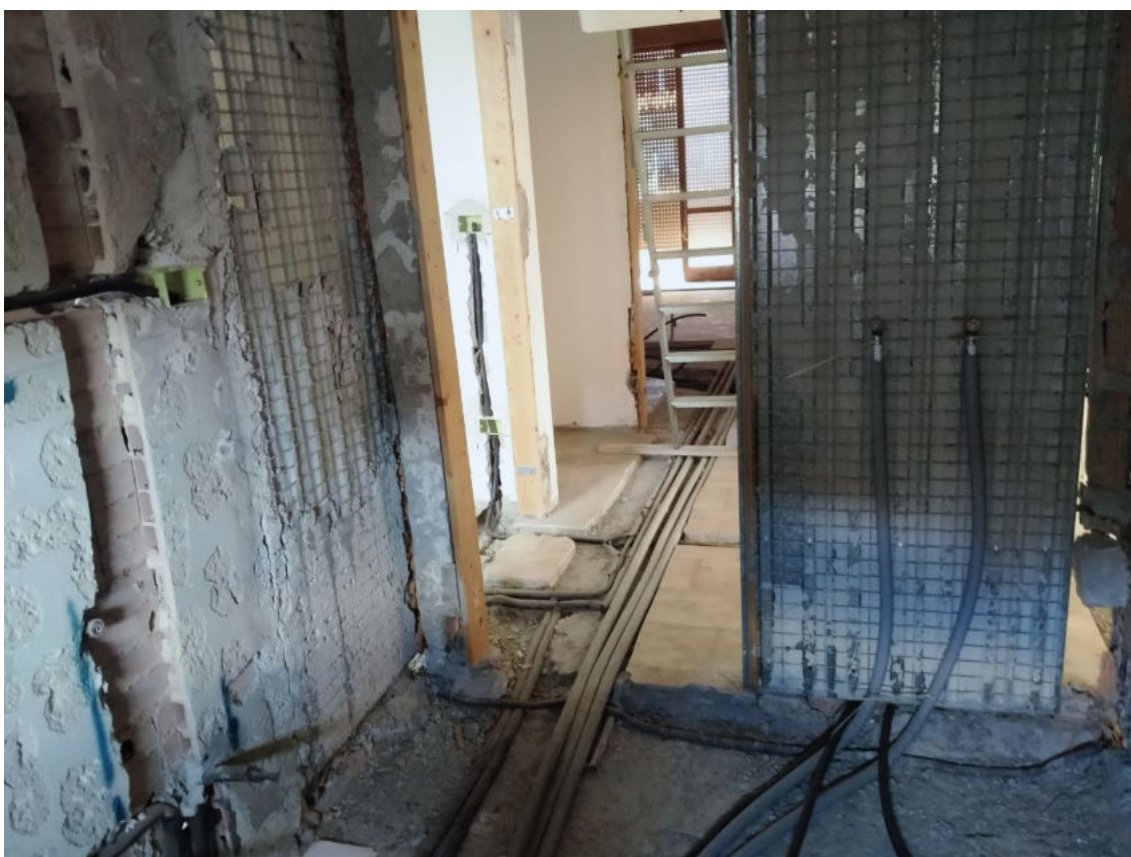
Fot. 9 – Vista dei lavori nella zona disimpegno.
