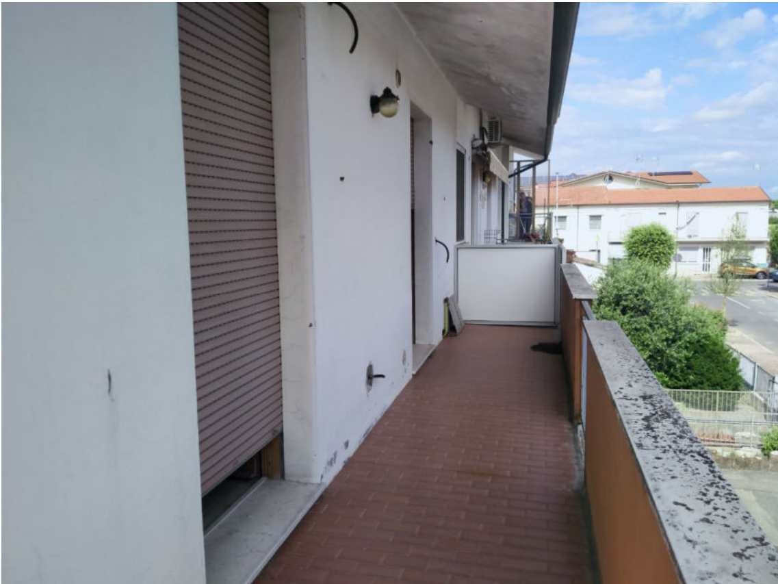
Fot. 13 – Vista esterna dei balconi.
