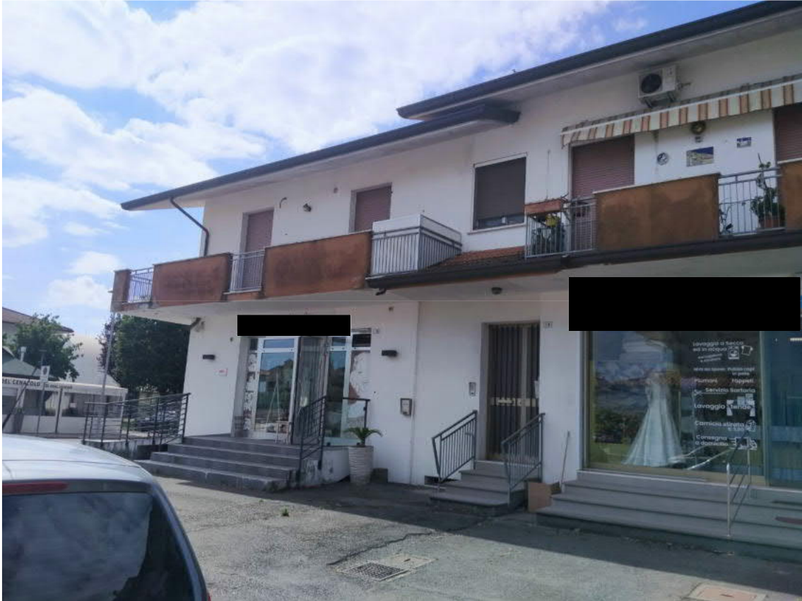
Fot. 1 – Vista parziale dell’edificio. A fianco della lavanderia l’ingresso all’appartamento.
