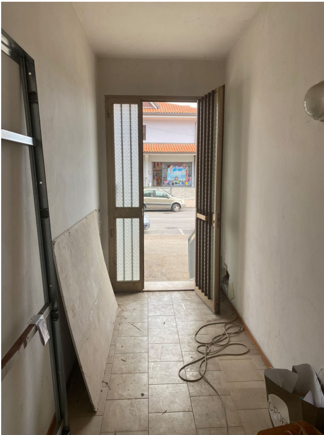
Fot. 5 – Vista della porta di ingresso all'unità immobiliare.
