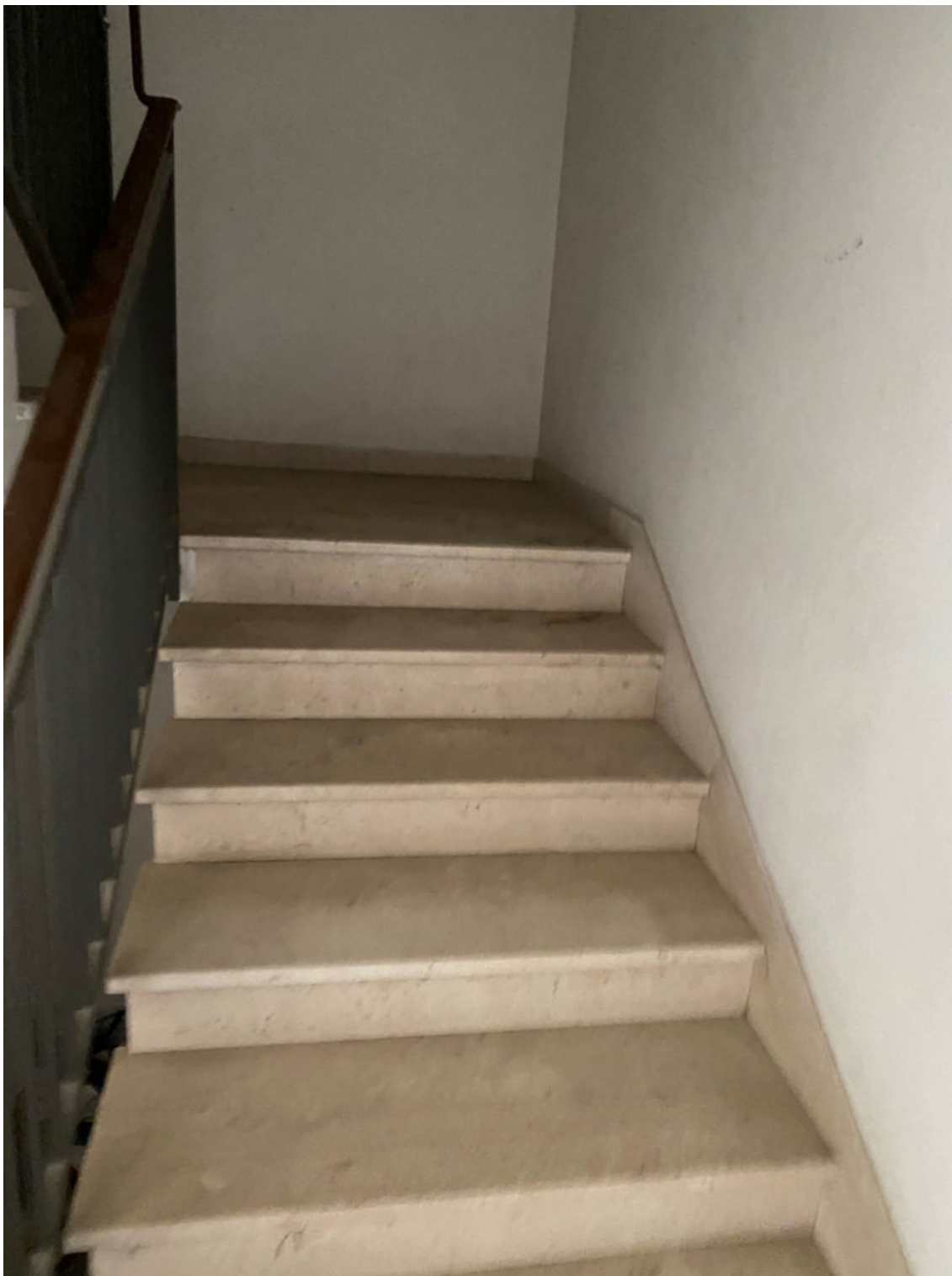
Fot. 6 – Vista della scala interna che conduce all’unità immobiliare.
