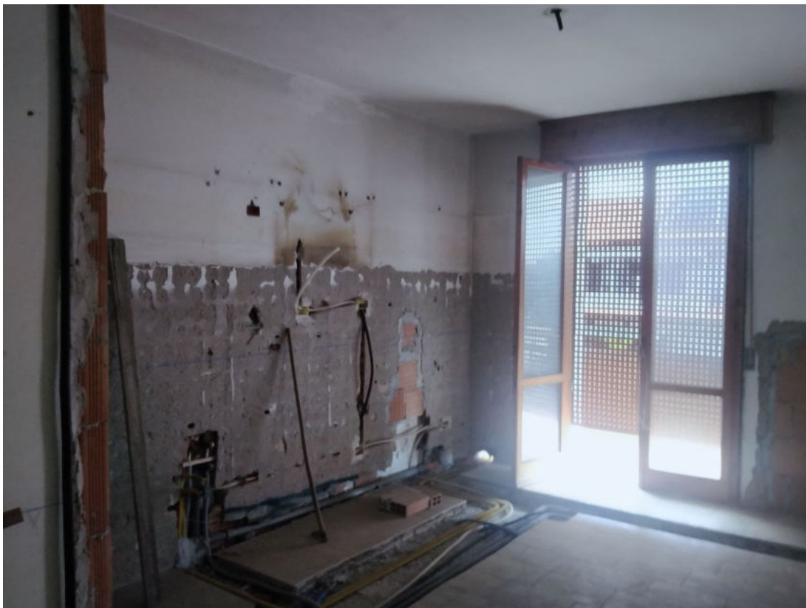
Fot. 8 – Vista dei lavori nella parete della cucina.
