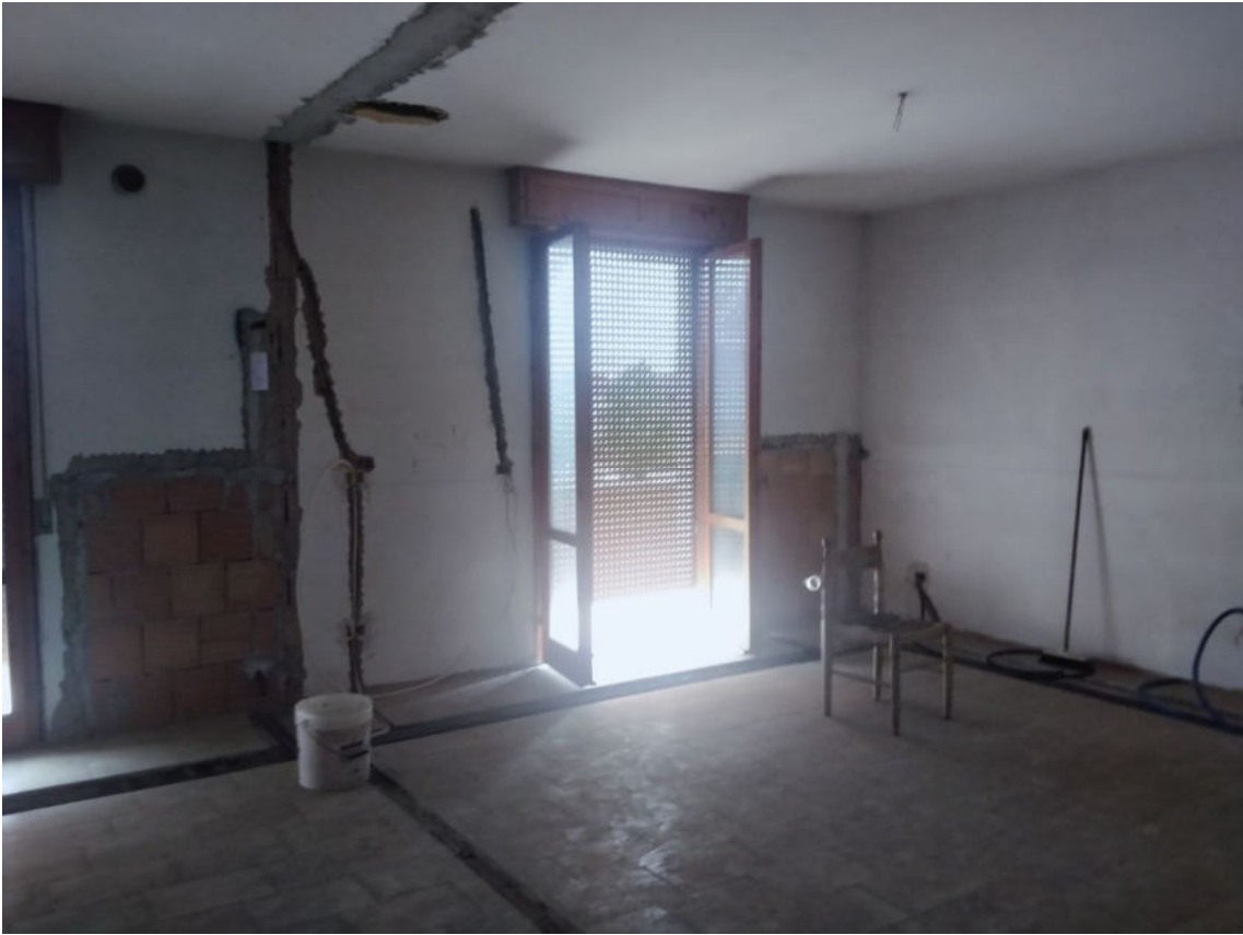
Fot. 14 – Vista dei lavori nella zona soggiorno.
