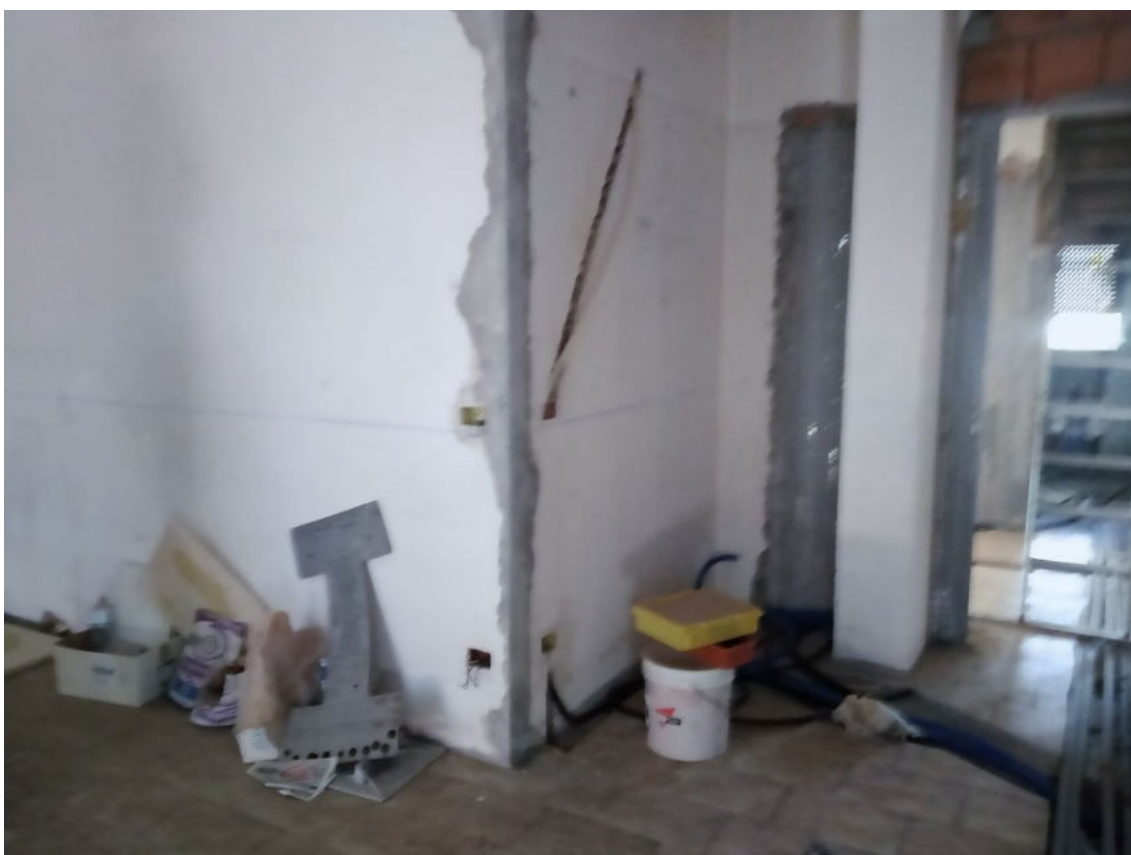
Fot. 11 – Vista dei lavori nella nelle camere dal letto.
