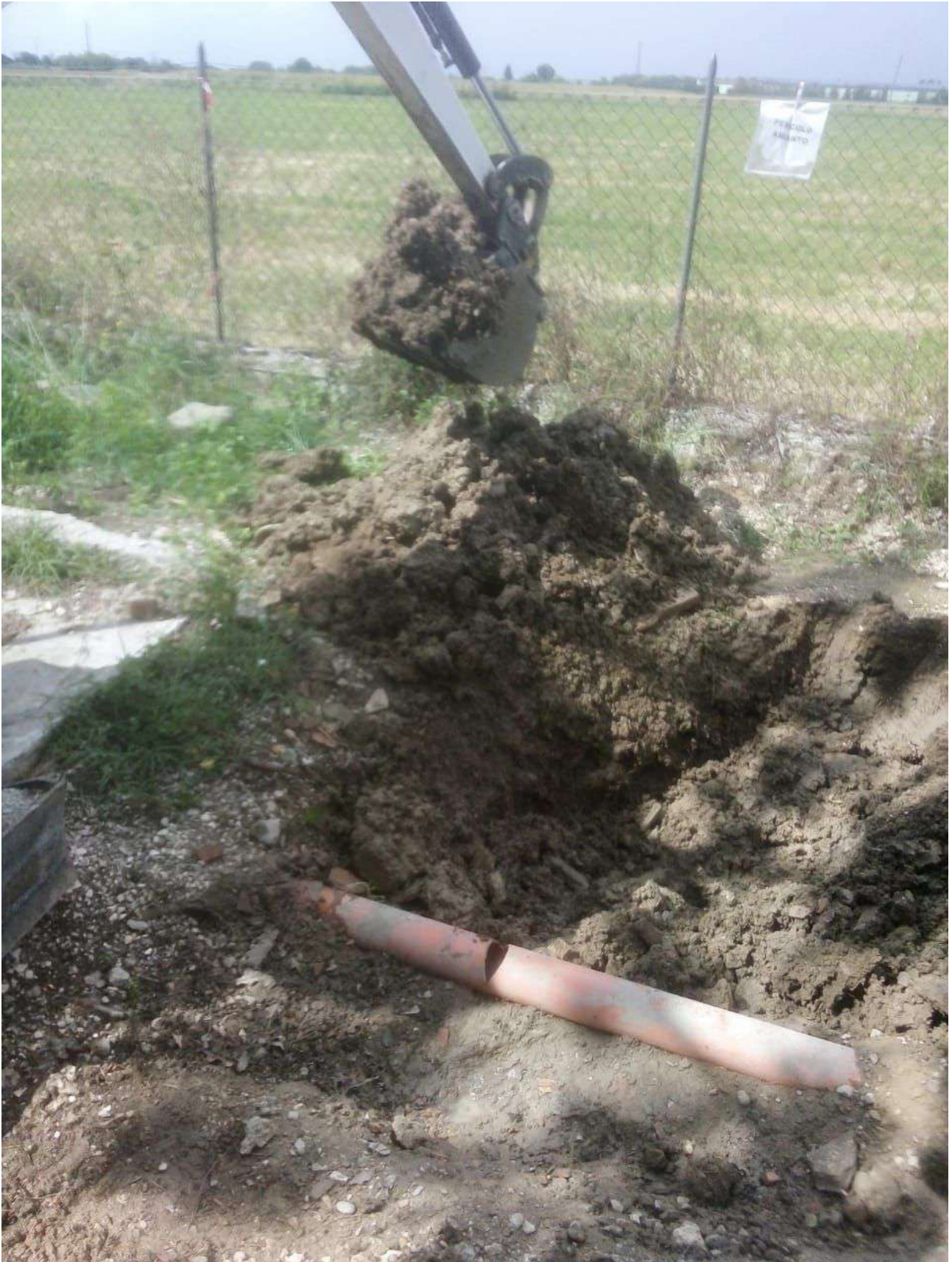
Area 7: ampliamento porzione di scavo effettuata in precedenza su commissione dell'esecutato per effettuare verifica puntuale
