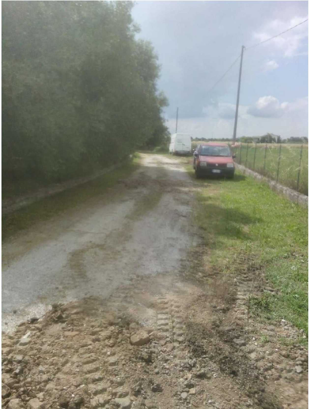
Vista di insieme dello stradello dopo aver ripristinato/richiuso gli scavi effettuati
