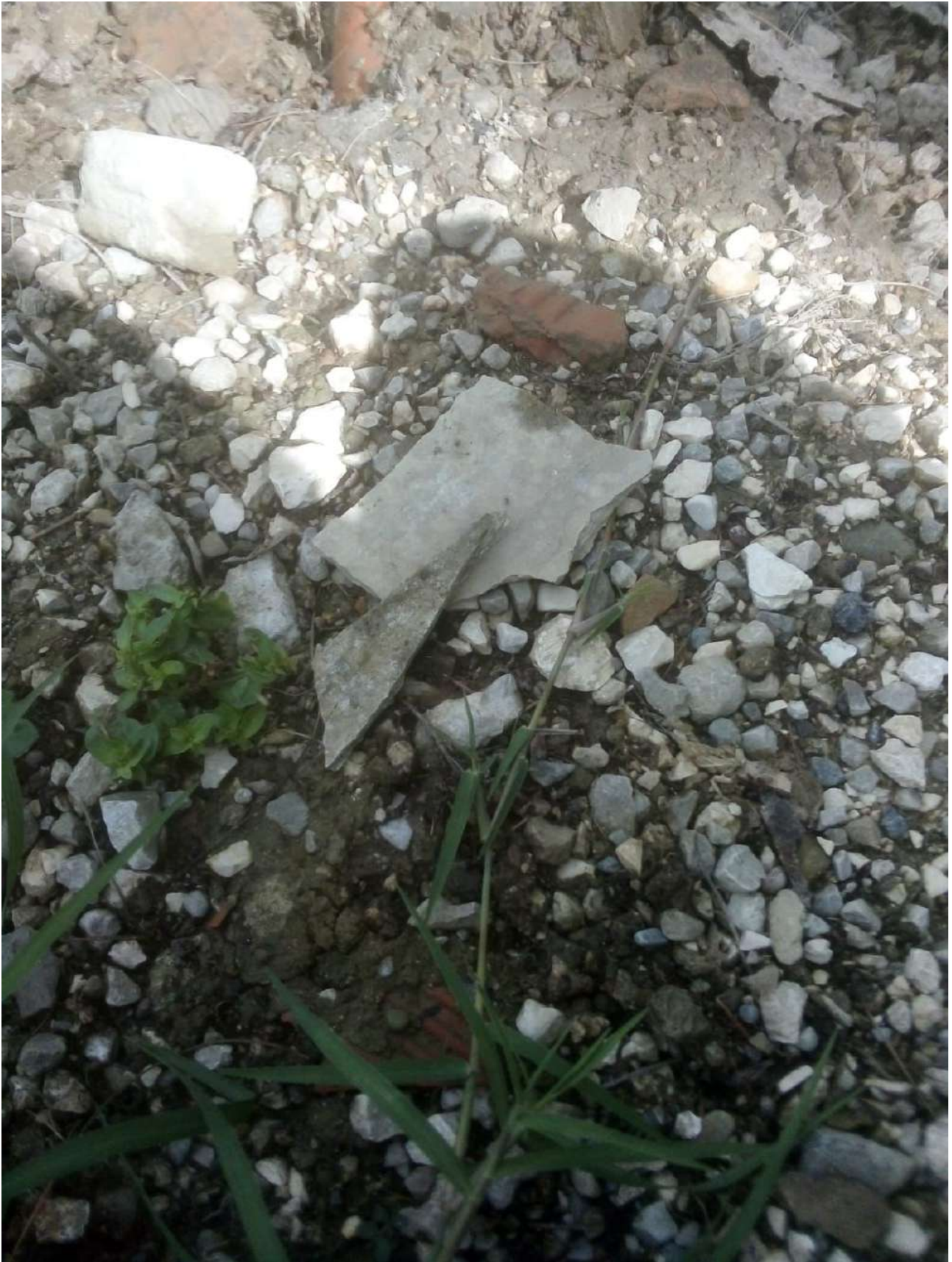
Area 7: presenza di alcuni frammenti di amianto
