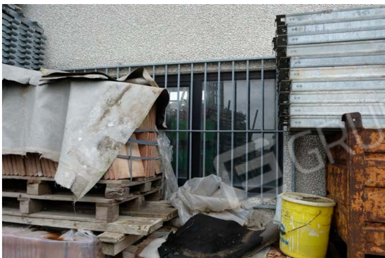
foto n.19 – particolare della finestra, vista dall'esterno, e dell'inferriata a protezione anti-intrusione
