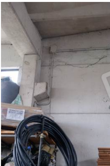
foto n.30 – particolare tipologia della struttura e dell'impianto elettrico del tipo industriale a vista
