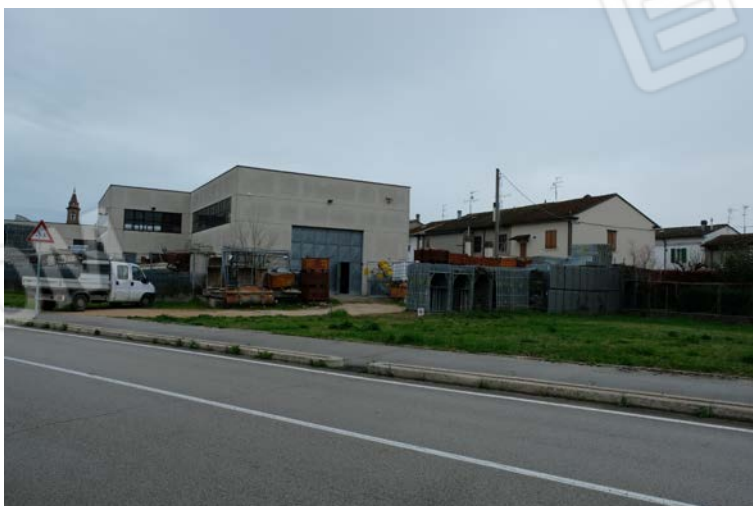
foto n.1-2 - veduta del fabbricato oggetto di procedura dalla via O. Palme
