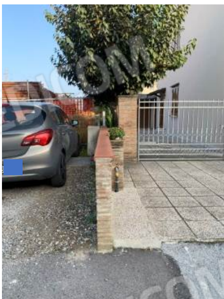
foto n.9-10-11 – veduta della nicchia del contatore del gas, presumibilmente al servizio della particella 525 ubicato lato via Cesenatico
