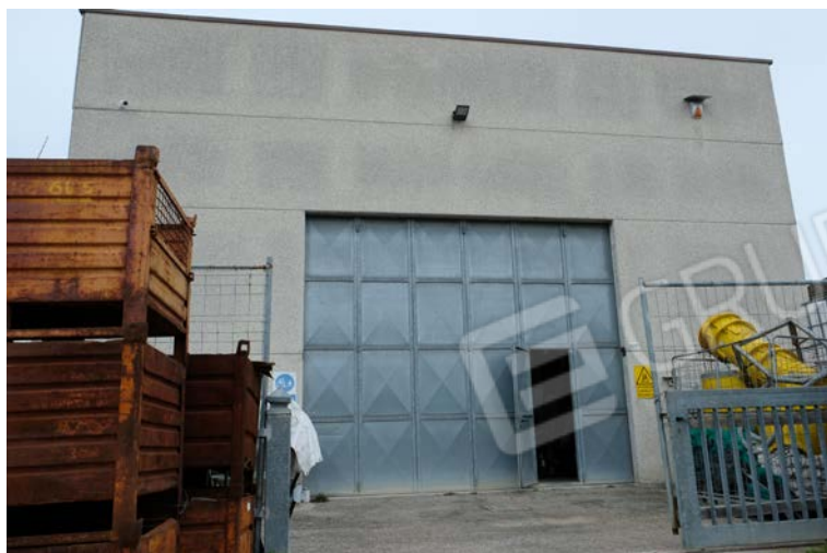
foto n.12 - veduta del fronte del fabbricato oggetto di procedura
