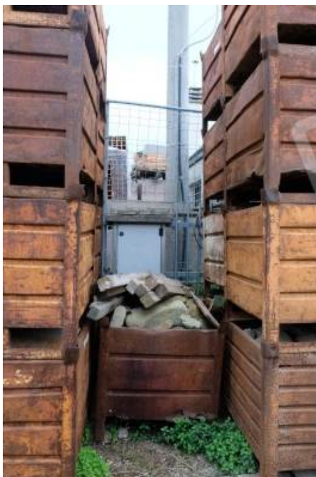
foto n.34 – veduta della nicchia del contatore della luce, ubicata lungo il percorso di accesso al capannone dalla via Cesenatico
