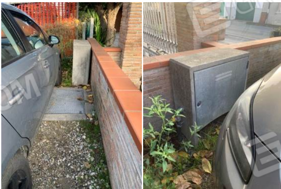
foto n.7-8 – particolare dei pilastri per la predisposizione di un cancello per l'accesso alla particella 525 dalla via Cesenatico, e della rete di cantiere per impedirne attualmente l'accesso.
