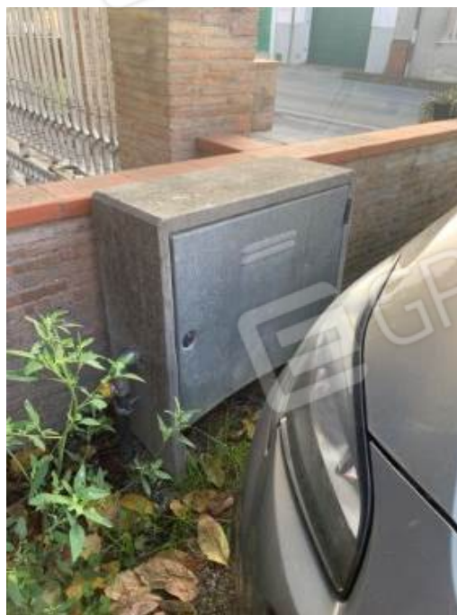
foto n.35-36 – veduta della nicchia del contatore del gas, ubicata lungo il percorso di accesso al capannone dalla via Cesenatico e, presumibilmente (visto che non è mai stato possibile aprire il pozzetto a causa dei veicoli costantemente parcheggiati sopra) del pozzetto a terra del contatore dell'acqua.
