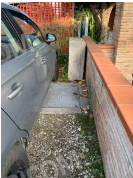
foto n.35-36 – veduta della nicchia del contatore del gas, ubicata lungo il percorso di accesso al capannone dalla via Cesenatico e, presumibilmente (visto che non è mai stato possibile aprire il pozzetto a causa dei veicoli costantemente parcheggiati sopra) del pozzetto a terra del contatore dell'acqua.
