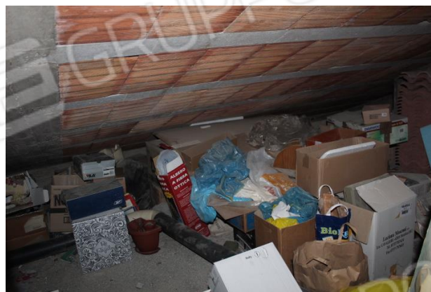
SOTTOTETTO AL GREZZO
