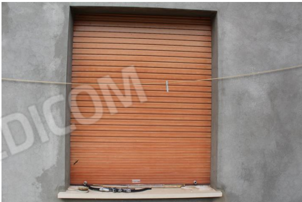
PARTICOLARE AVVOLGIBILE ESTERNO IN PVC
