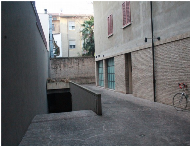
Ingresso vano scala esclusivo dal cortile interno
