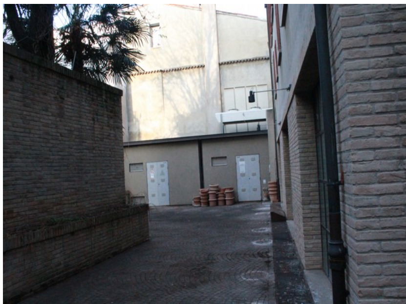
vista della cabina dalla corte sul retro del palazzo
