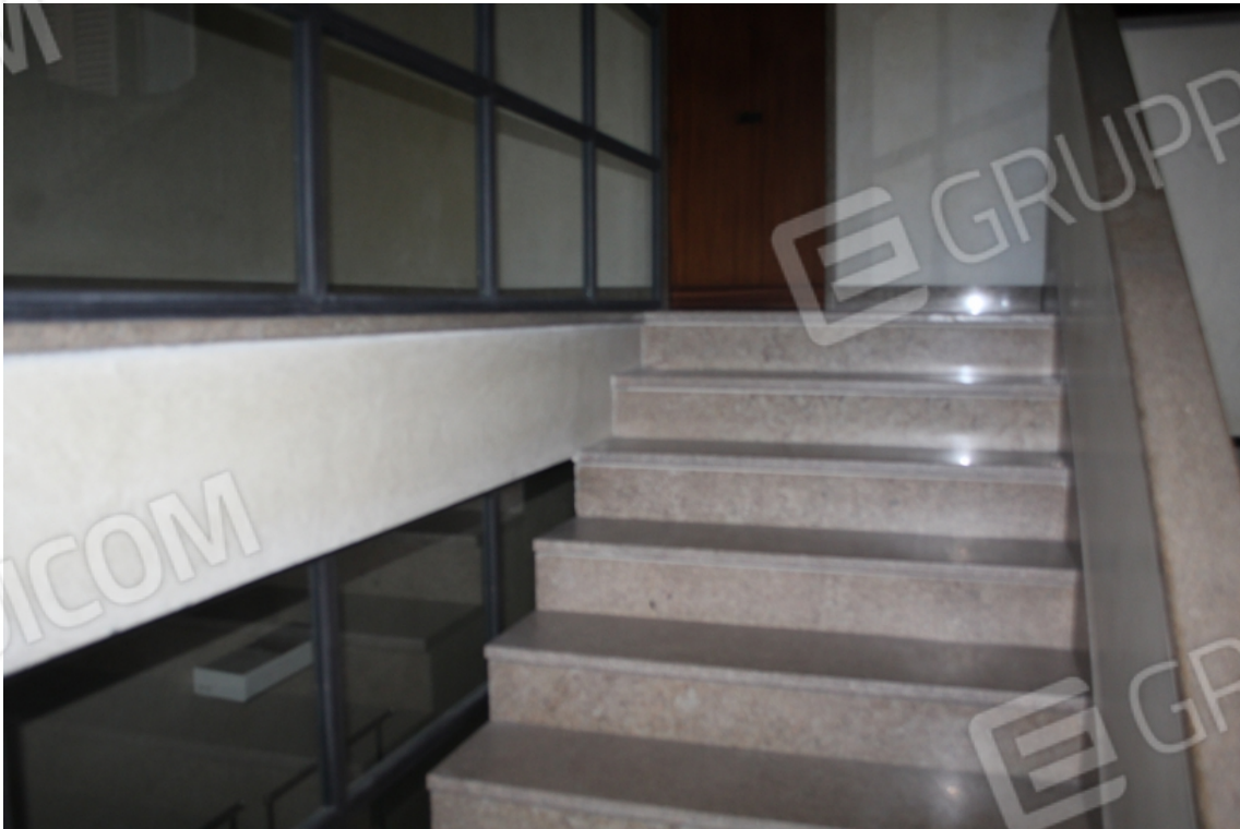
vano scala comune
