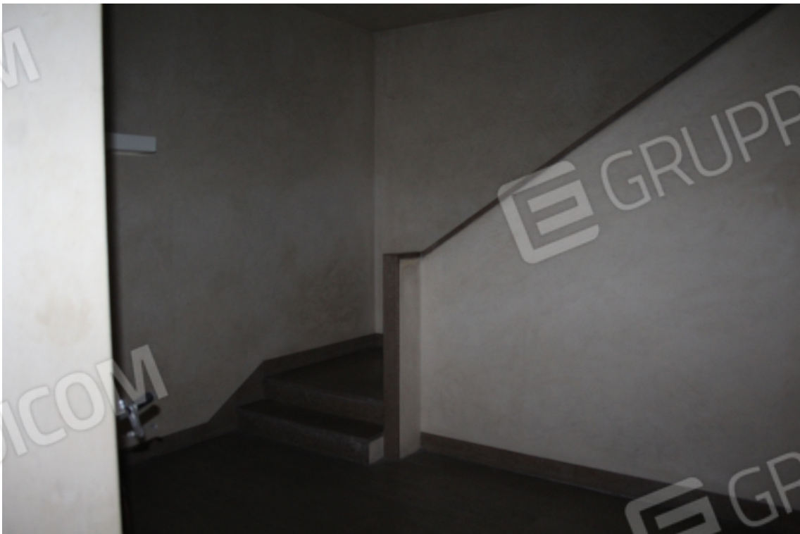
vano scala comune
