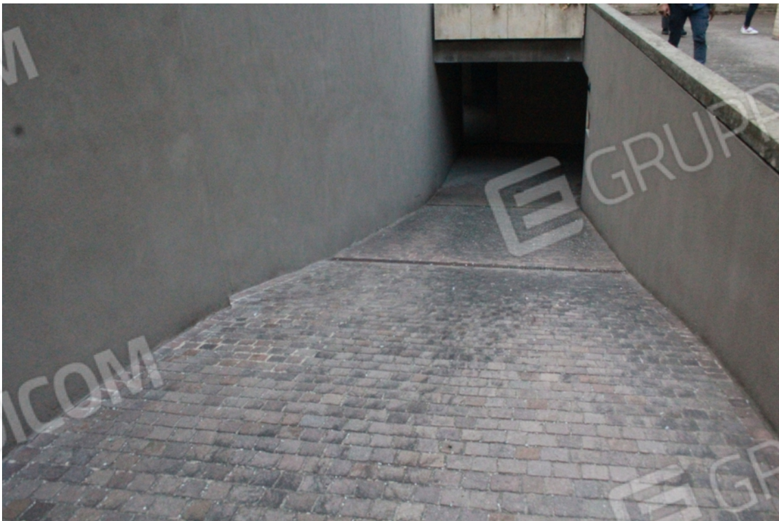
rampa esterna di accesso al piano seminterrato
