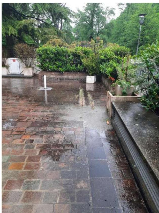
4 – VISTA ESTERNA Area esterna retro
