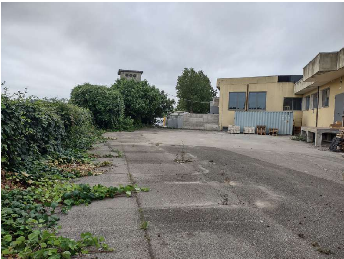
FOTO 6 La corte sul retro destinata a parcheggio con la cabina elettrica
