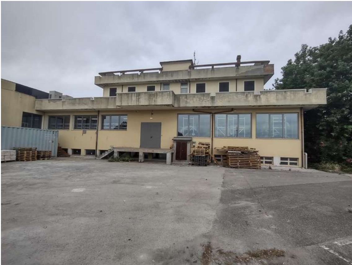
FOTO 5. Retro (al piano terra e nel seminterrato unità immobiliare ad uso uffici di altra proprietà)
