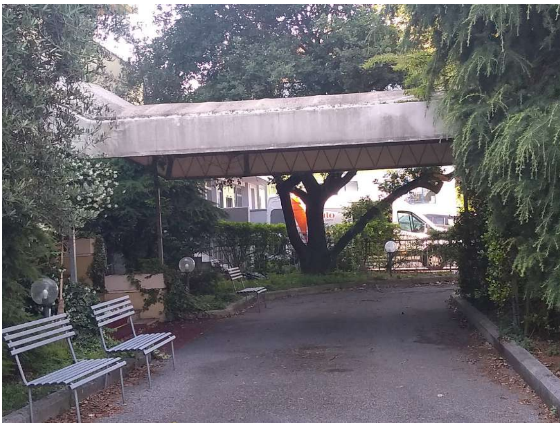
FOTO 8. Fronte del fabbricato: tettoia sul fronte dell'ingresso all'albergo
