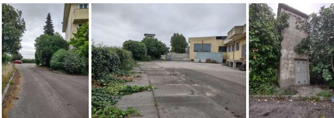
Piano Terra: porzioni di corte destinata a percorsi e parcheggio; la cabina elettrica
