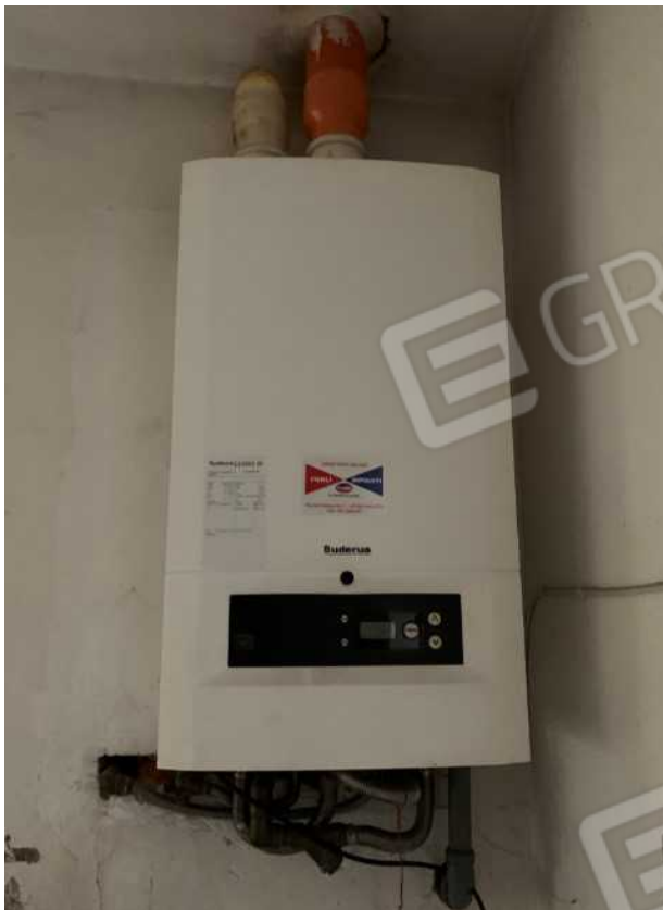
PARTICOLARE CALDAIA A CONDENSAZIONE INSTALLATA NEL 2008
