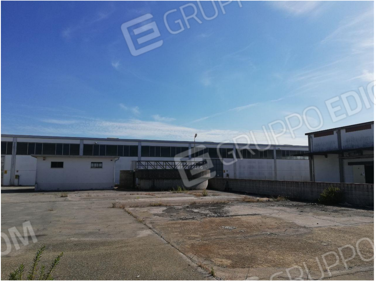
Figura 1 VISTA ESTERNA LOTTO 2
