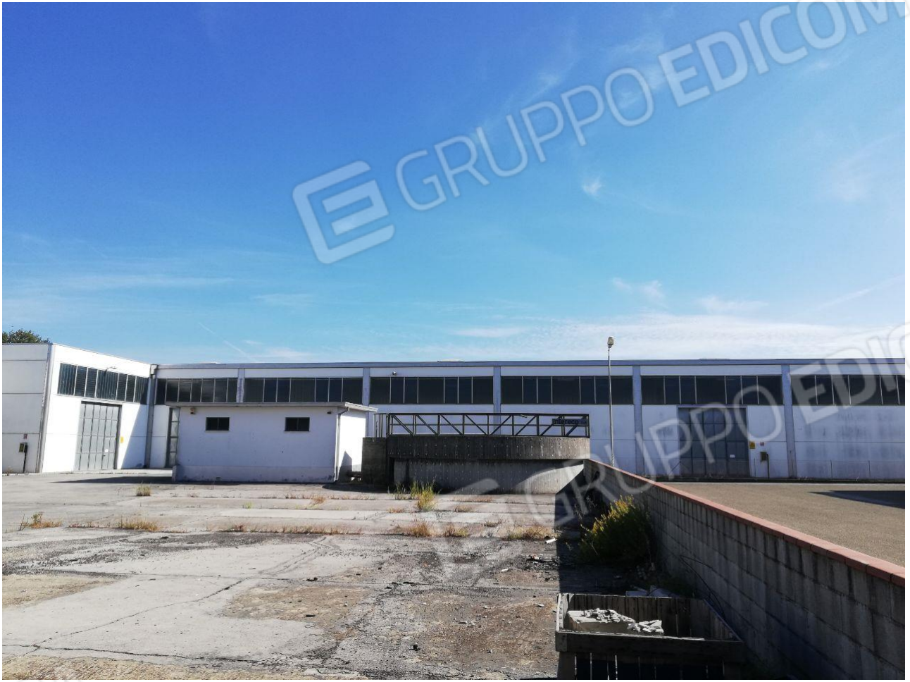
Figura 2 VISTA ESTERNA LOTTO 2
