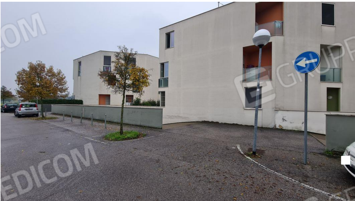
Rampa di accesso interrato lotti 8-15
