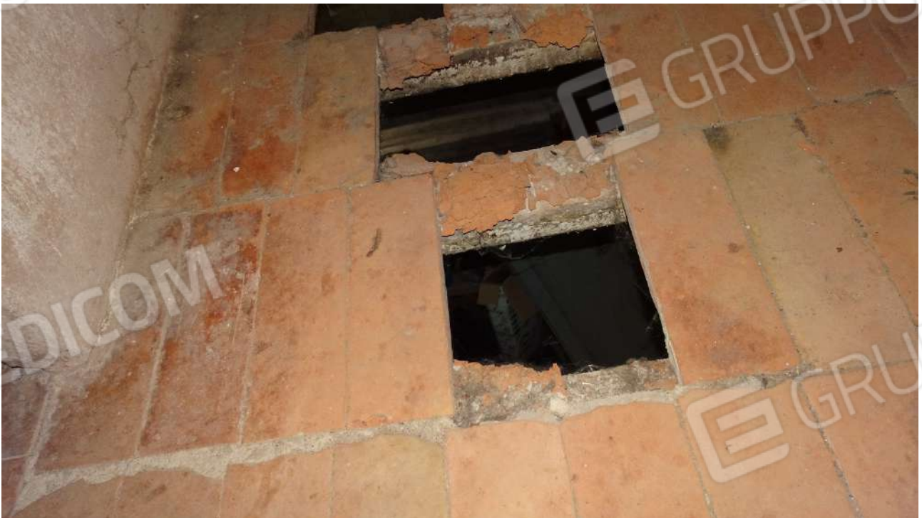
Foto 36_particolare solaio
