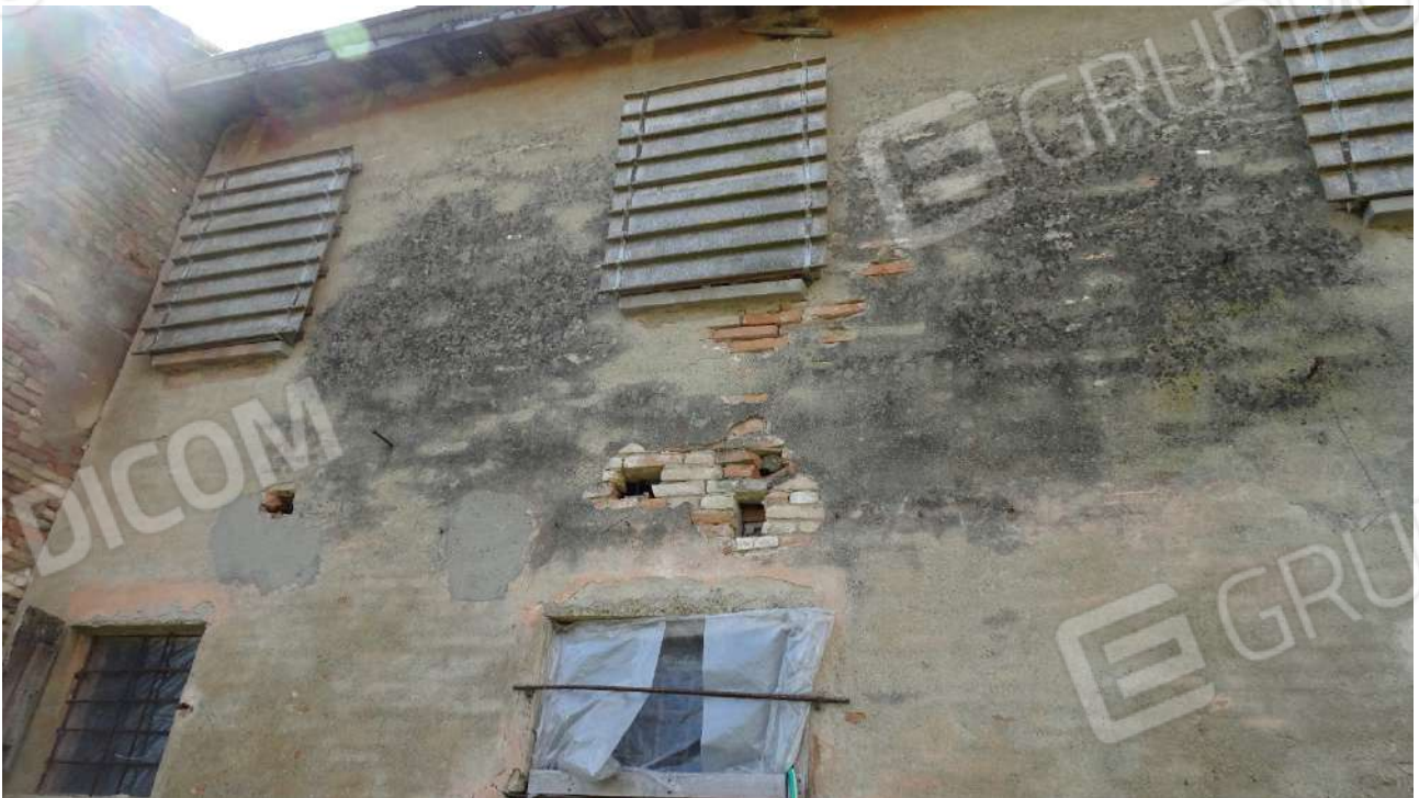
Foto 08_particolare muro esterno
