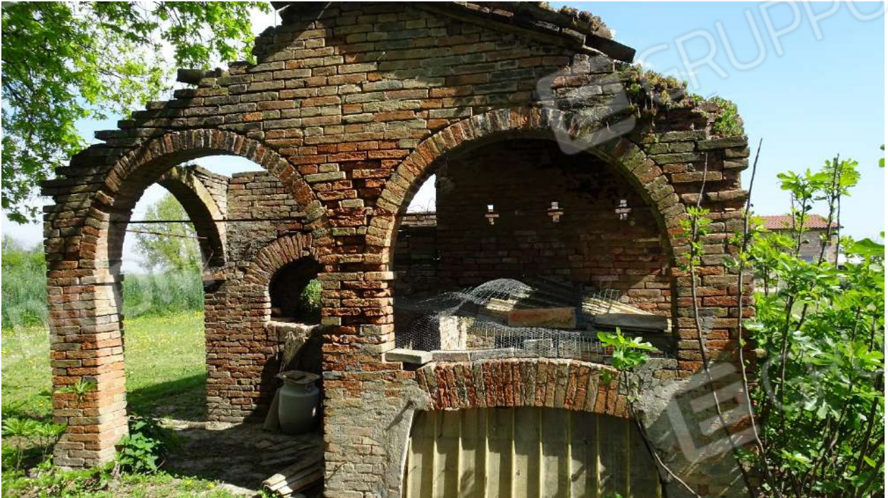
Foto 12_sgombero in corpo staccato
