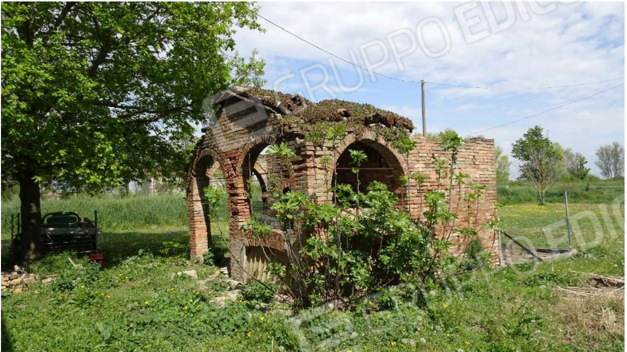
Foto 11_sgombero e forno in corpo staccato
