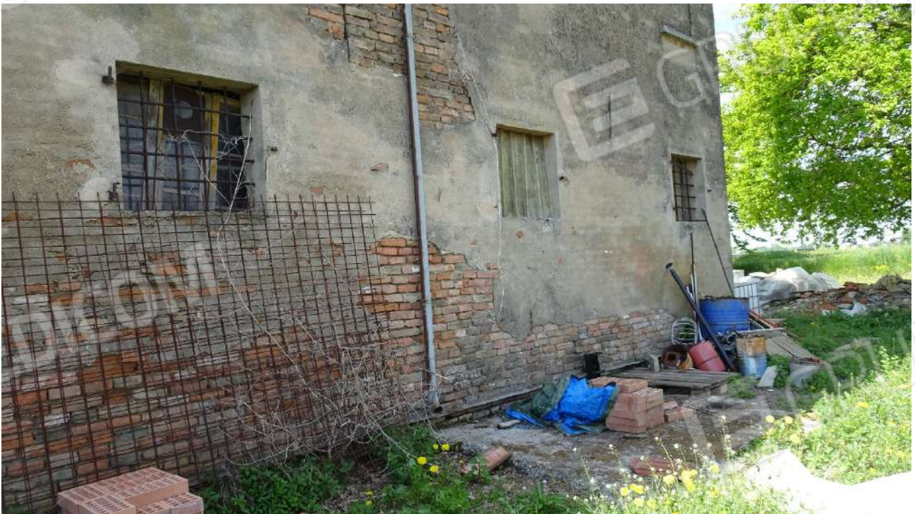
Foto 10_particolare muro esterno
