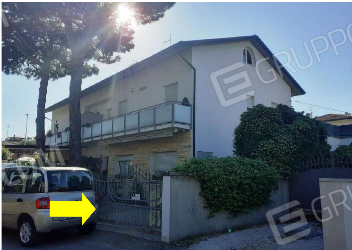
VISTA PROSPETTO E PROSPETTO EST DA VIA CASELLO DEL DIAVOLO CON INDICAZIONE DELL'ACCESSO CARRABILE
