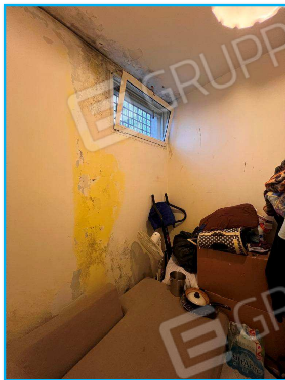
Appartamento: Danni da infiltrazione
