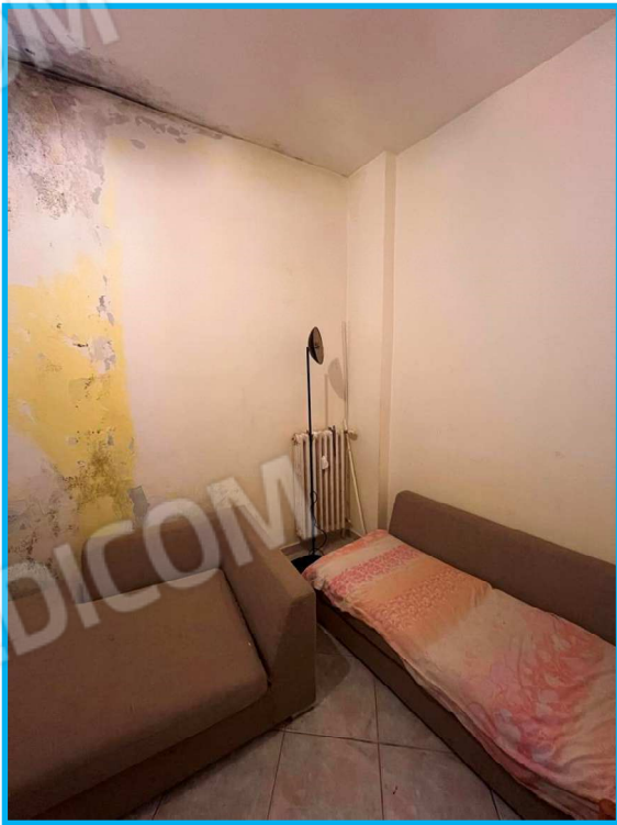
Appartamento: Danni da infiltrazione
