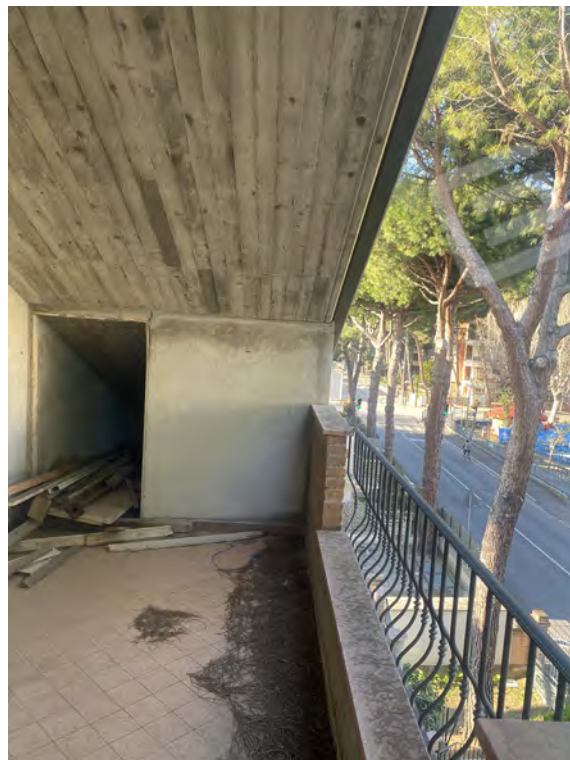
Foto 8 terrazzo sottotetto non accessibile
