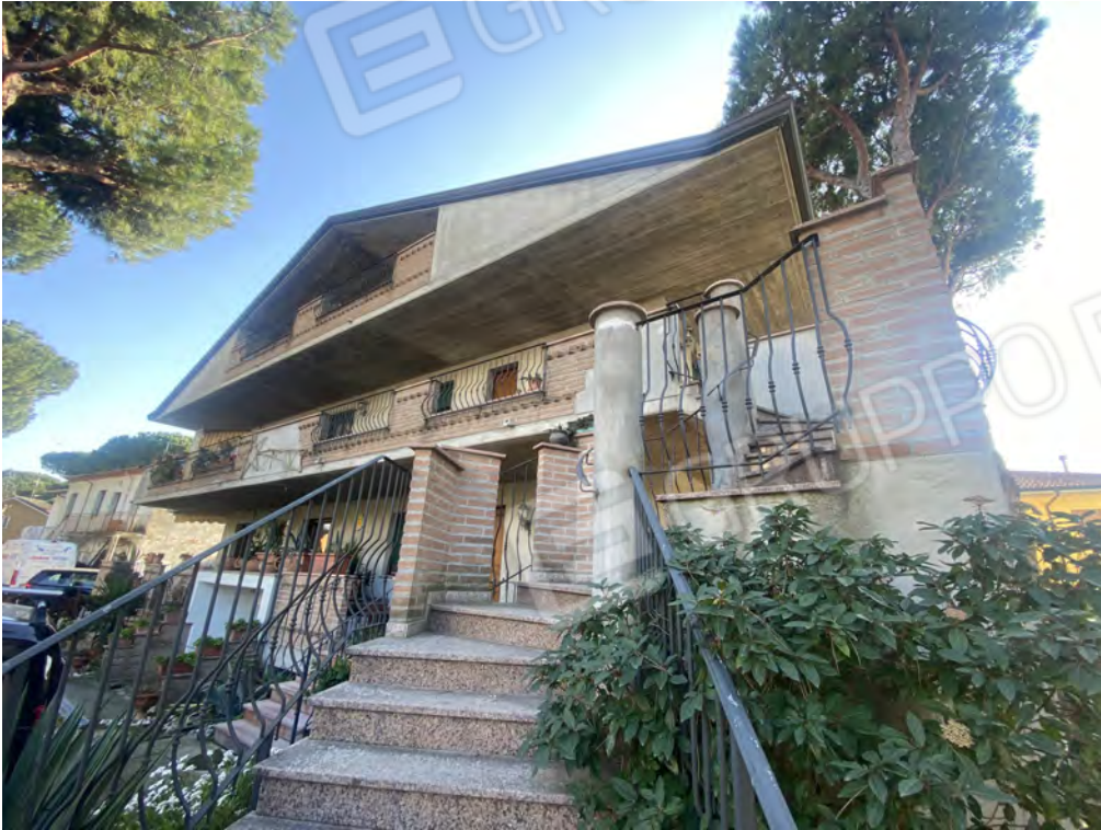
Foto 1 esterno lato est
