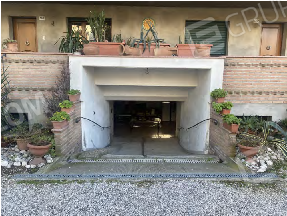
Foto 2 ingresso al piano seminterrato
