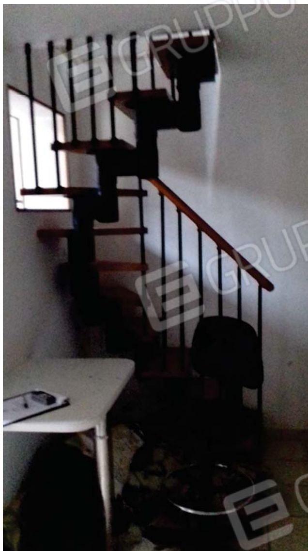
FOTO 9 SCALA DI ACCESSO AL PIANO PRIMO UNITA' SULRETRO
