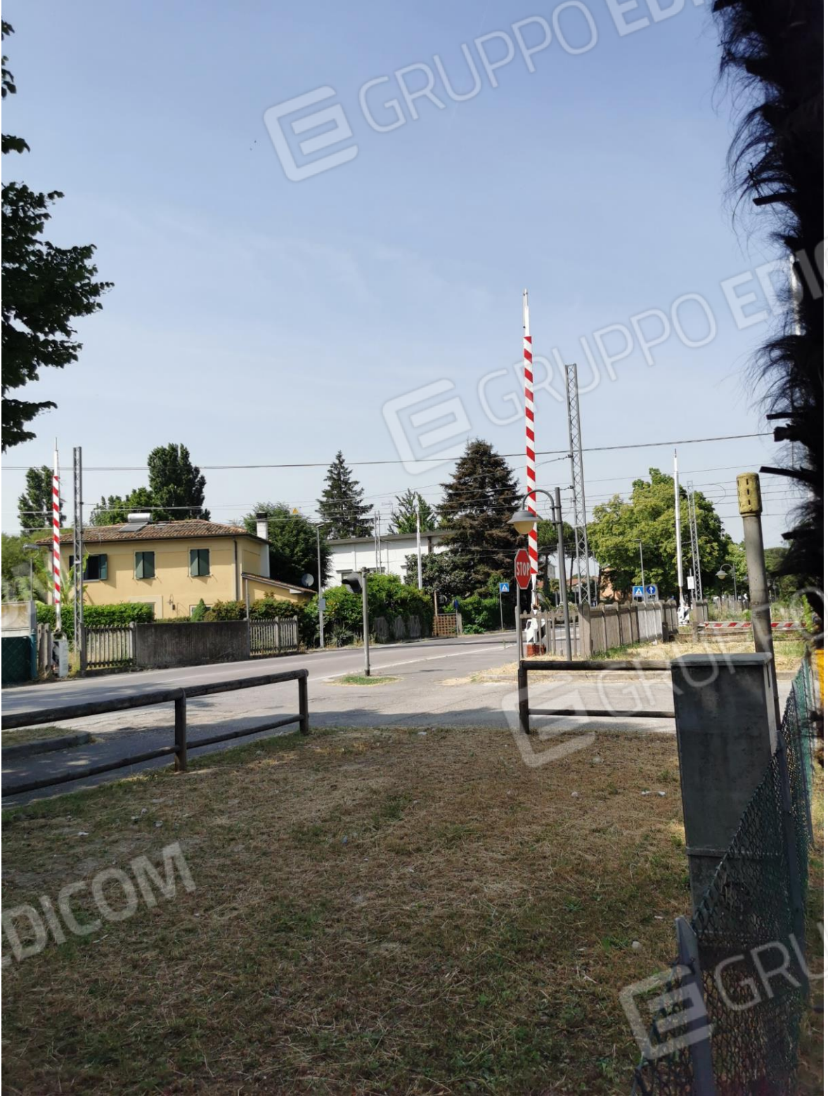
Accesso via Sinistra Canale Superiore
