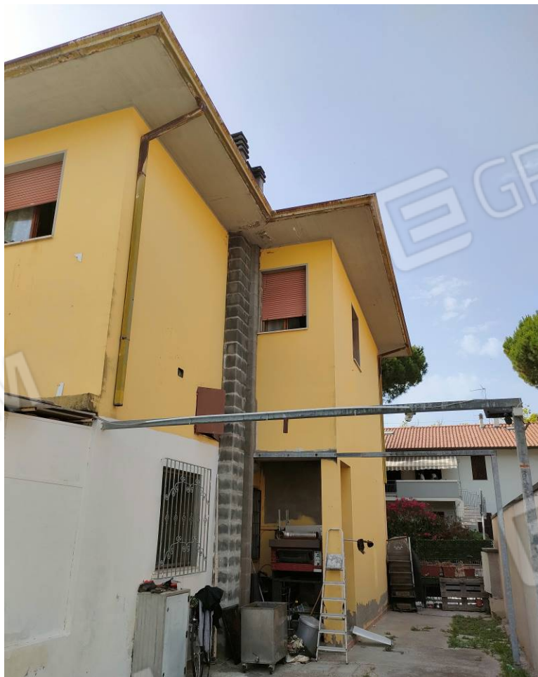
Vista lato est del fabbricato ed in particolare del laboratorio al piano terra
