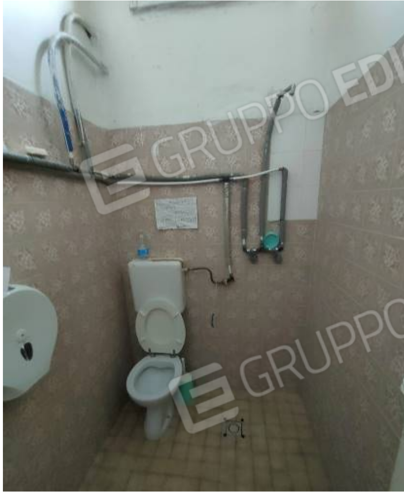
Vista interna del bagno
