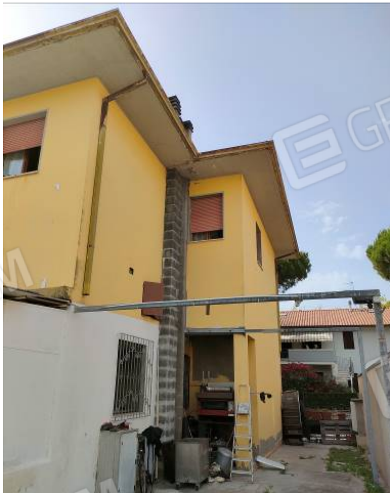
Vista lato est del fabbricato, in particolare dell'appartamento al piano primo
