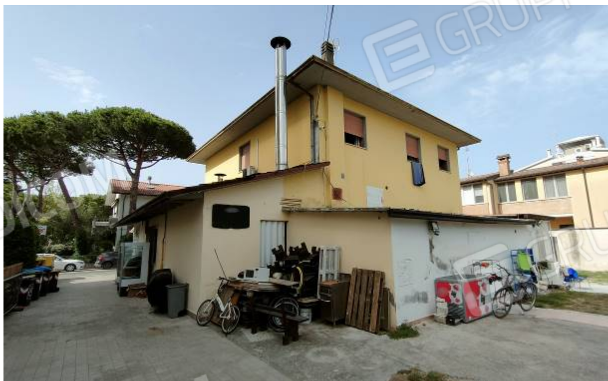
Vista lato sud-ovest del fabbricato, in particolare dell'appartamento al piano primo
