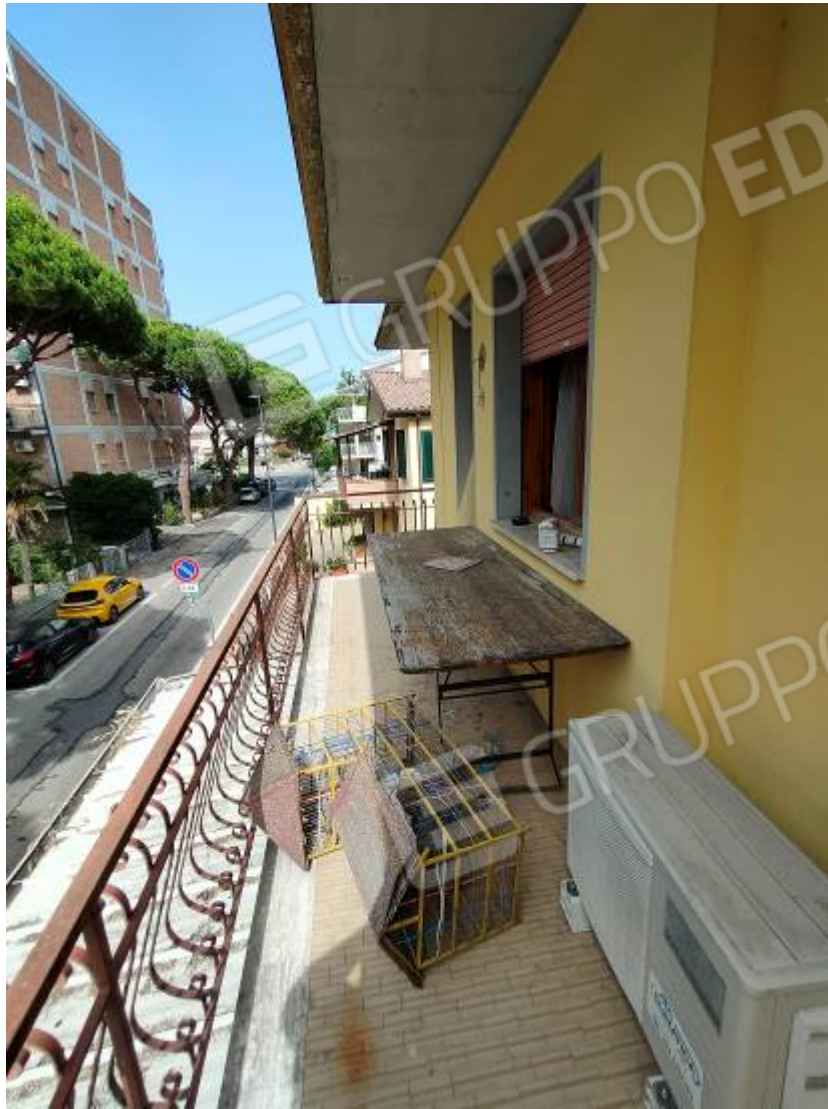
Vista del balcone che affaccia su via Verghereto, lato nord
