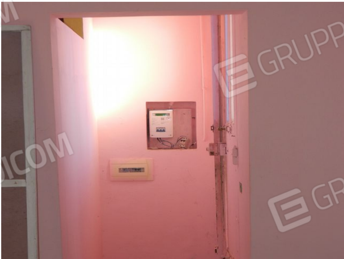
FOTO 12 – Ingresso al piano rialzato
