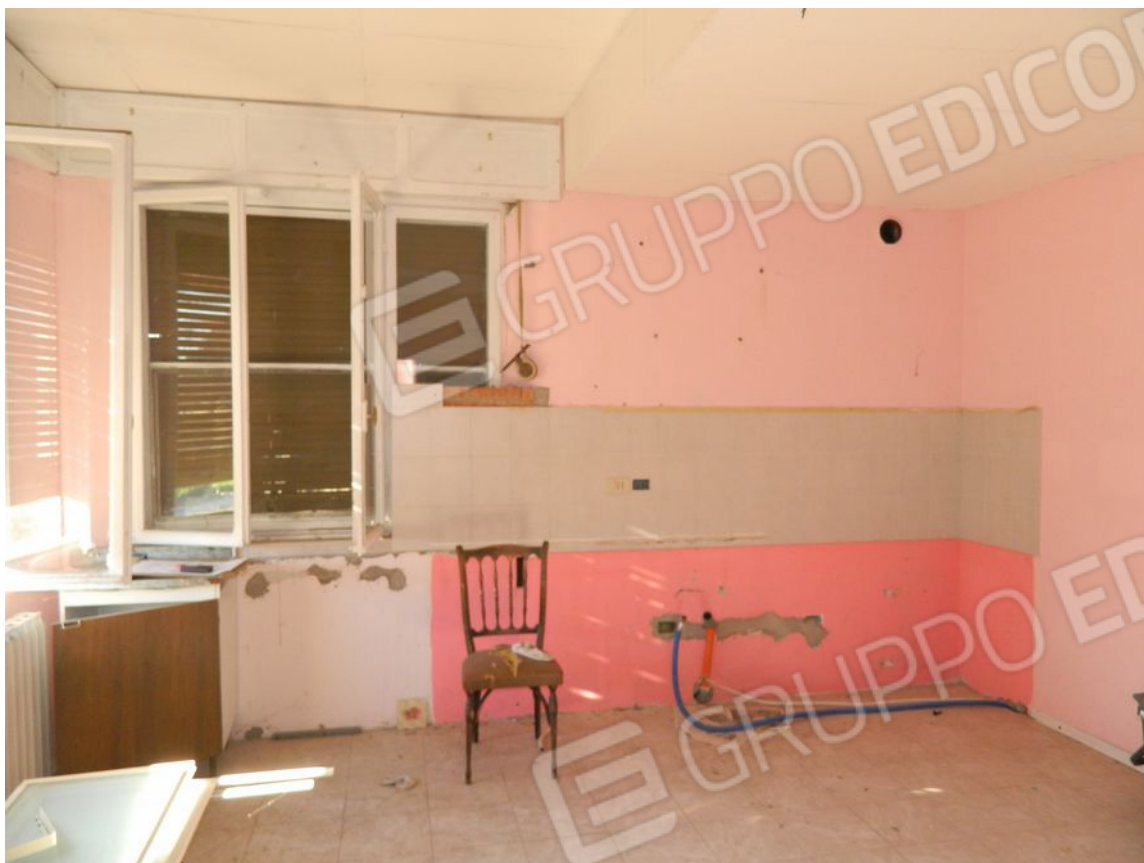
FOTO 15 – Soggiorno: angolo cottura – attacchi impianto idrico e gas
