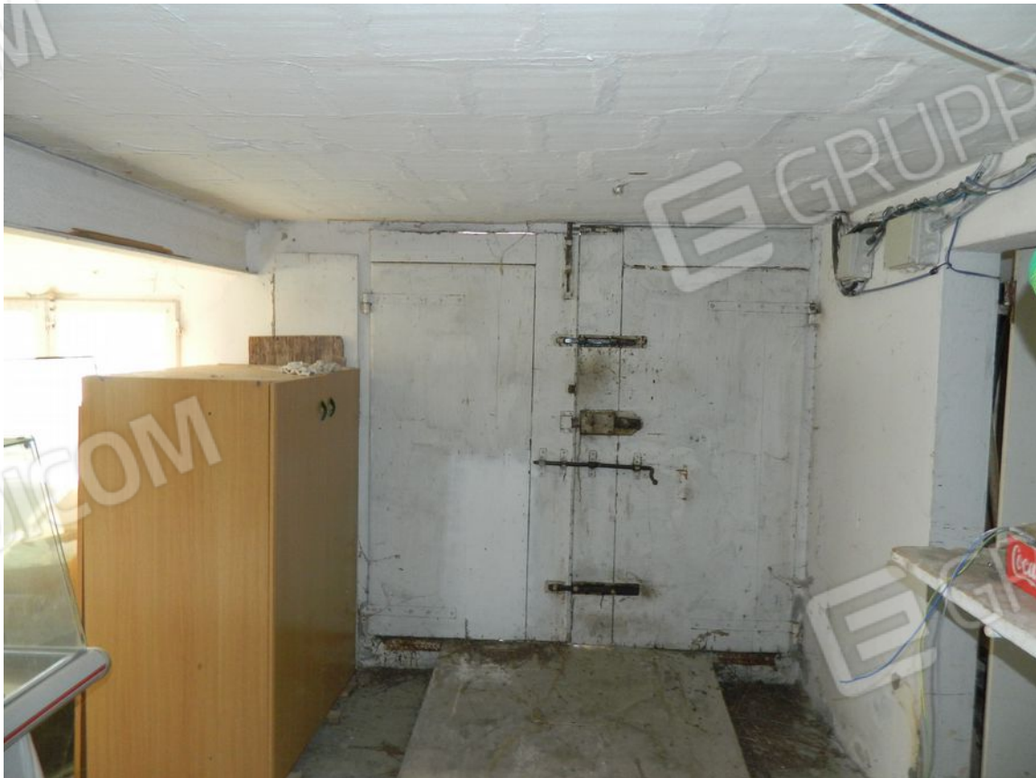
FOTO 26 – Locale di servizio (1): portoncino di accesso alla corte esterna
