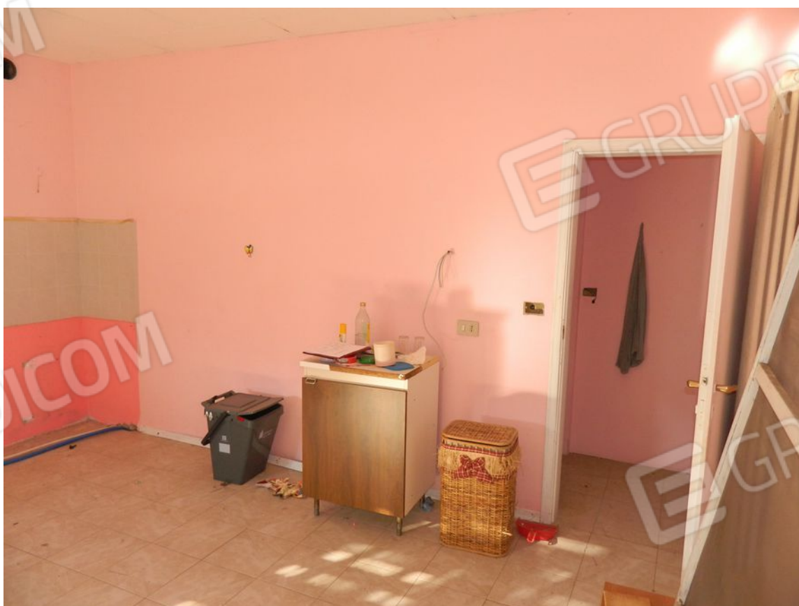
FOTO 16 – Soggiorno: vano porta di accesso al disimpegno
