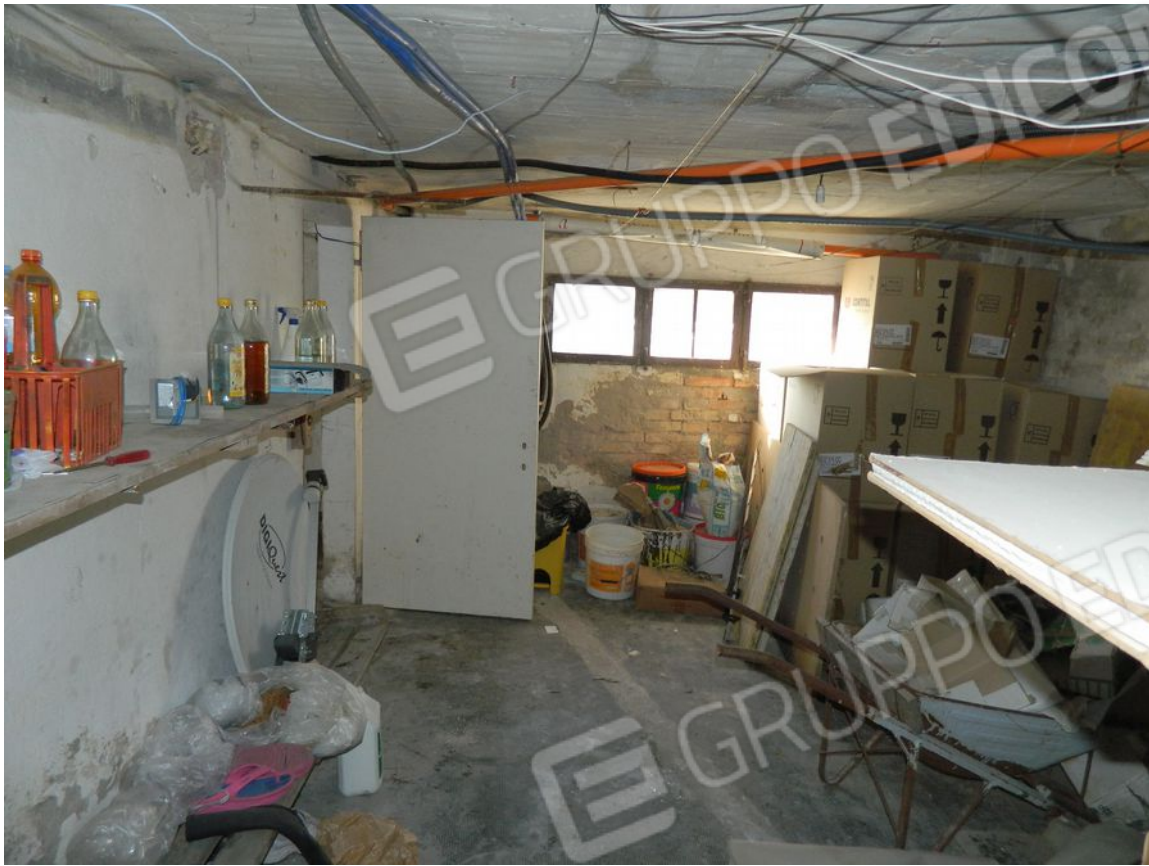
FOTO 27 – Locale di servizio (2) al piano seminterrato
