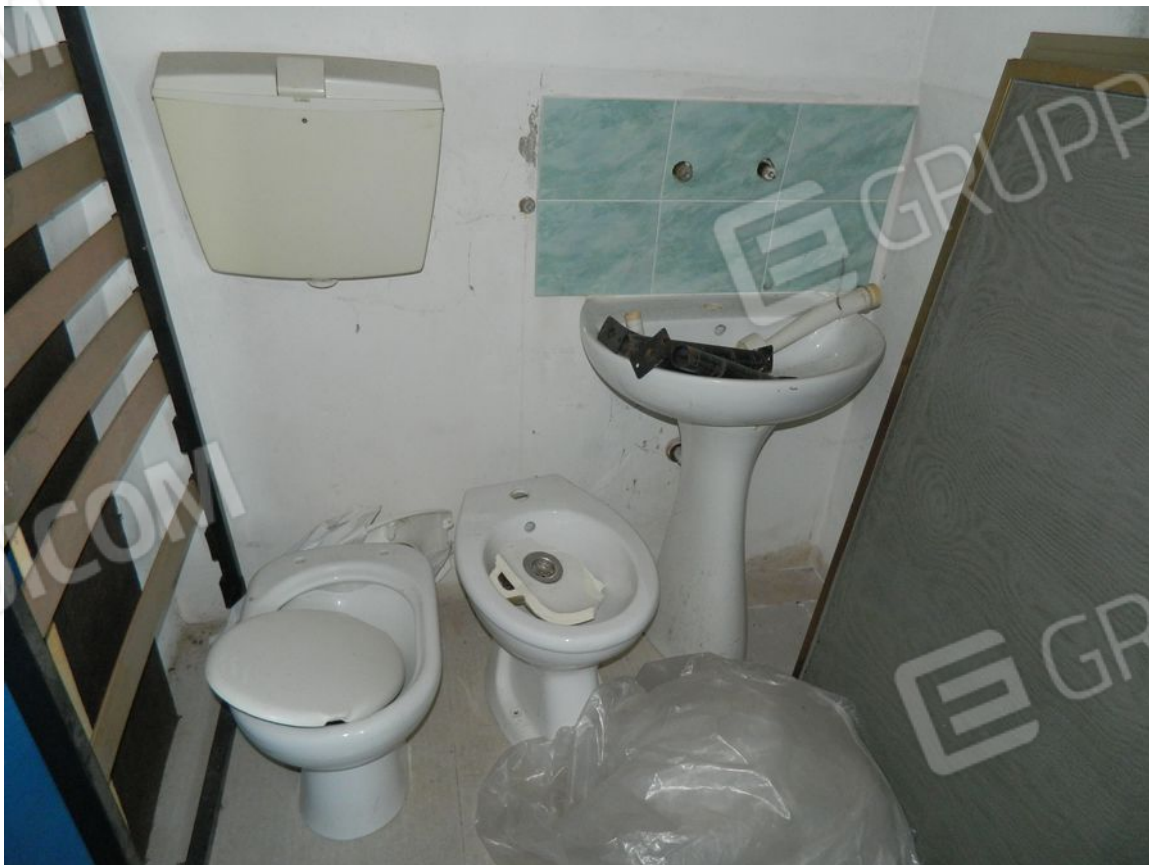
FOTO 10 – Bagno al piano terra: dettaglio sanitari
