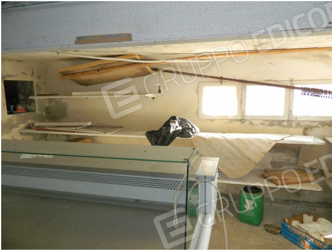
FOTO 25 – Locale di servizio (1) al piano seminterrato
