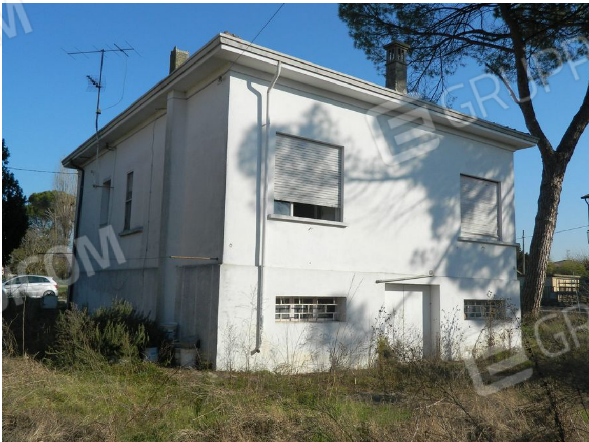
FOTO 4 – Immobile dalla corte esterna sul retro
