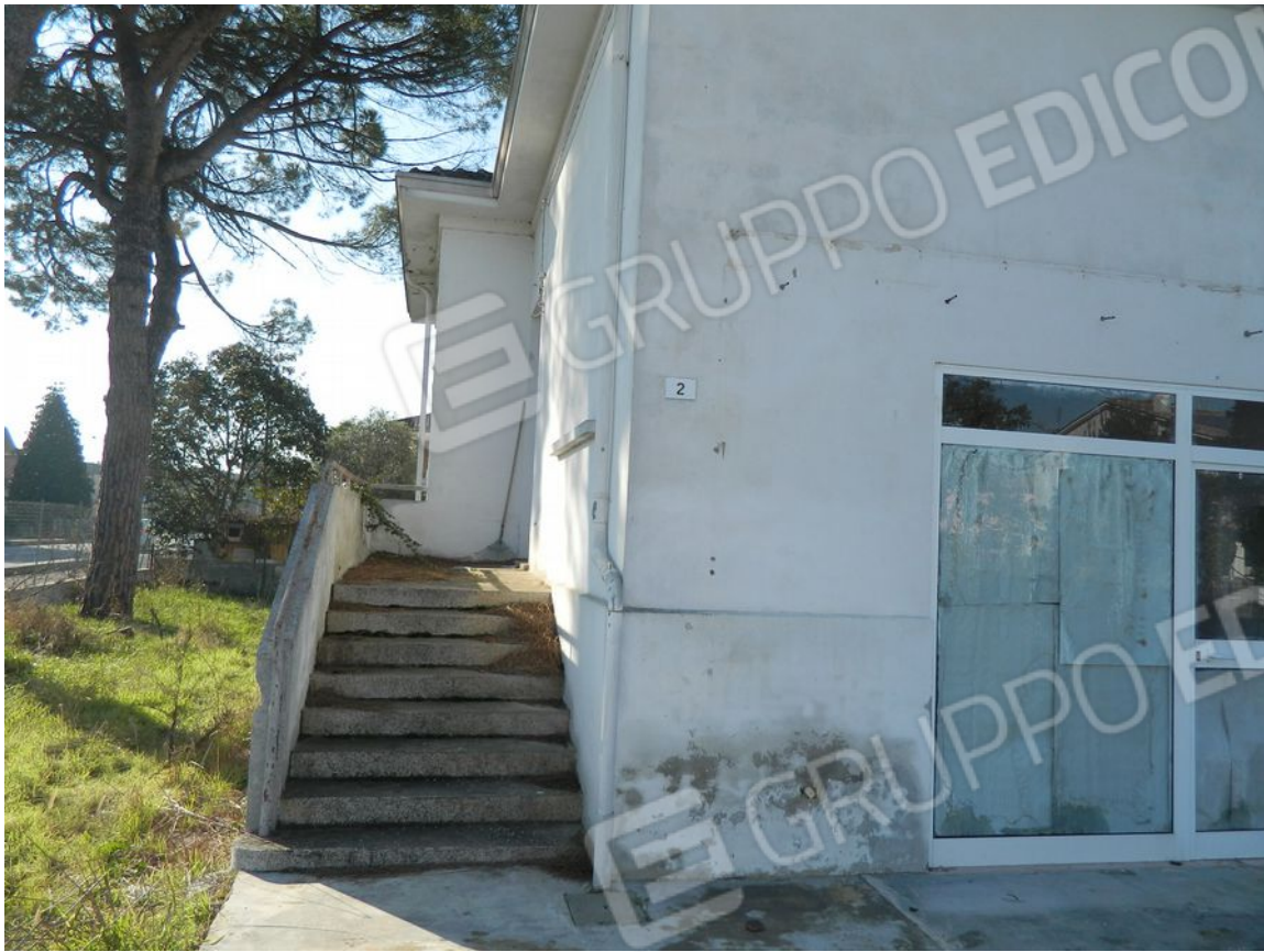
FOTO 11 – Scala esterna di accesso al piano rialzato
