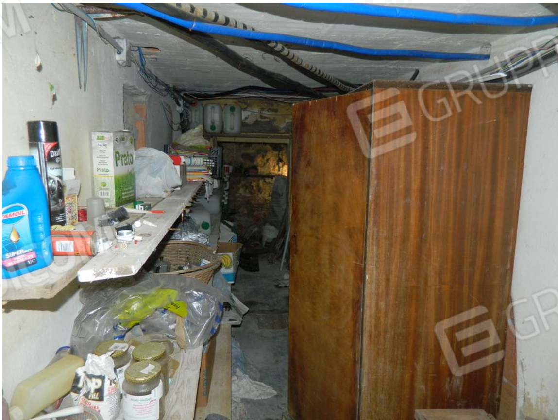
FOTO 28 – Locale di servizio (3) al piano seminterrato
