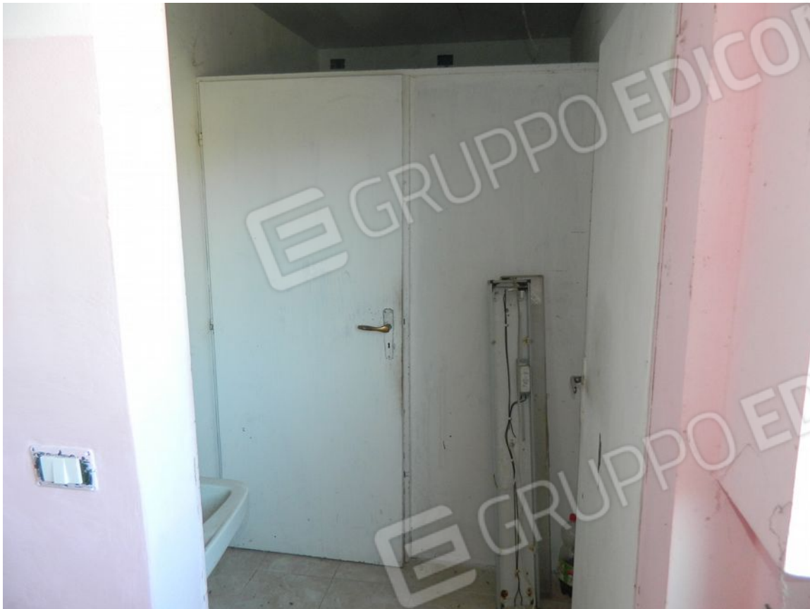
FOTO 9 – Bagno al piano terra: divisorio con struttura in legno
