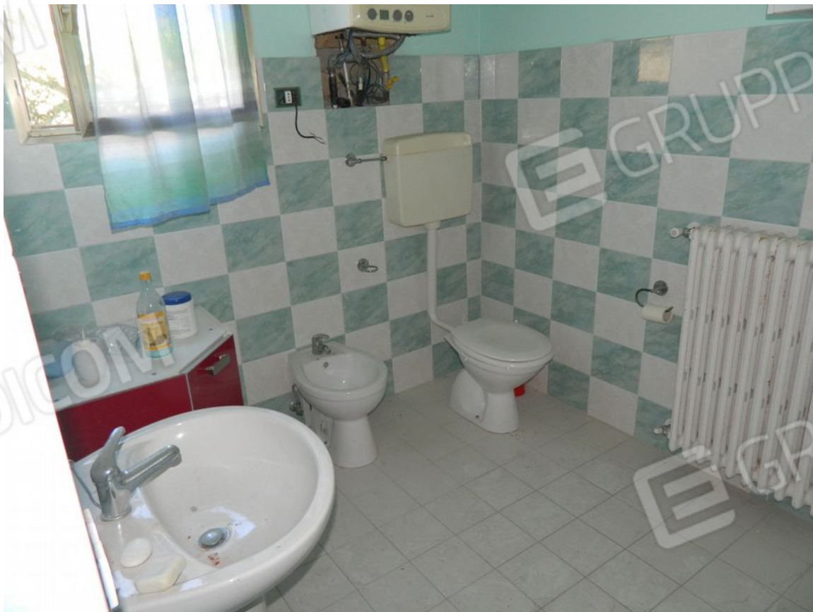
FOTO 22 – Bagno a piano rialzato: dettaglio sanitari
