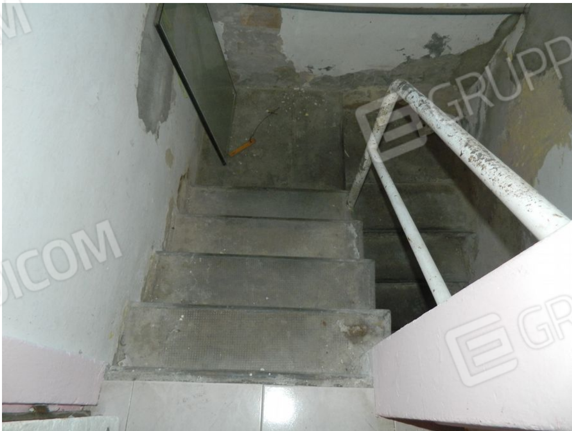
FOTO 24 – Vano scale di accesso al piano seminterrato
