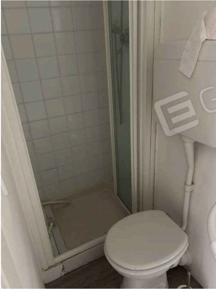
RIPOSTIGLIO TRASFORMATO IN BAGNO
