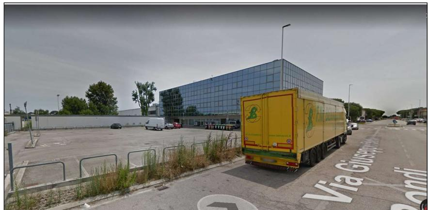
Situato ai civici 60, 62 e 62/A del Viale G. Di Vittorio, in angolo con la Via Bondi, l'edificio, costruito nei primi anni ottanta con intelaiatura in cemento armato e tamponature esterne in vetro, è di grande impatto volumetrico a pianta rettangolare semplice su tre piani fuori terra, ed è abbinato, da un lato al complesso immobiliare adiacente.
