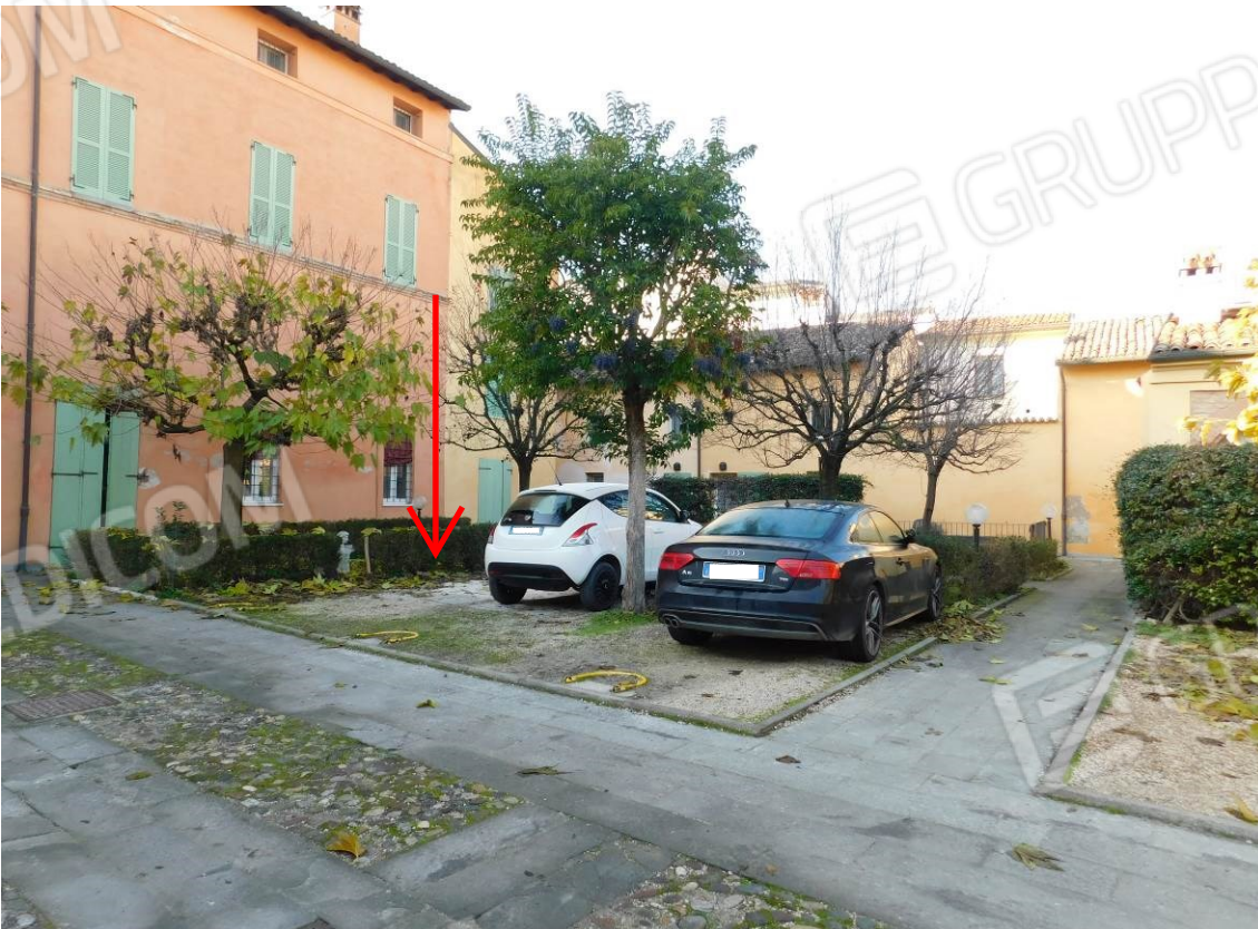
Foto 15 – Posto auto scoperto Sub 55.
