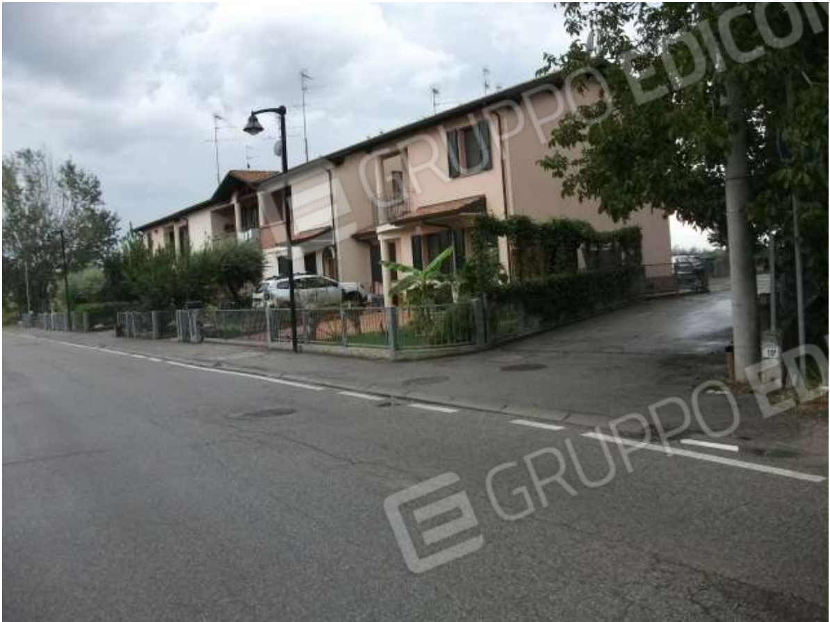
Fusignano - Via Pero n° 10: Vista particolare degli ingressi al condominio
