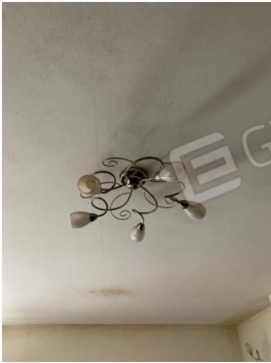
PARTICOLARI DEL DEGRADO DA MUFFE E CONDENZA ZONA SOGGIORNO – LATO OVEST E COPERTURA VERSO TERRAZZO
