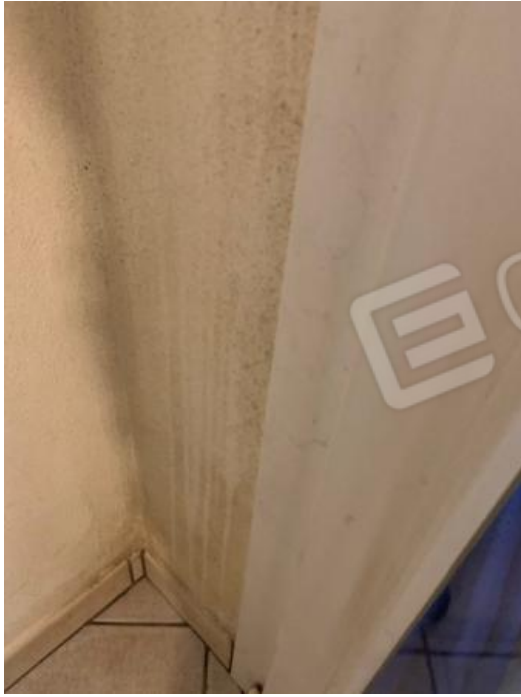
PARTICOLARI DEL DEGRADO DA MUFFE E CONDENZA ZONA CAMERA MATRIMONIALE – LATO OVEST E COPERTURA VERSO TERRAZZO
