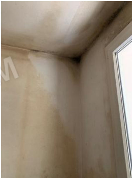
PARTICOLARI DEL DEGRADO DA MUFFE E CONDENZA ZONA CAMERA DOPPIA – LATO EST E COPERTURA VERSO TERRAZZO
