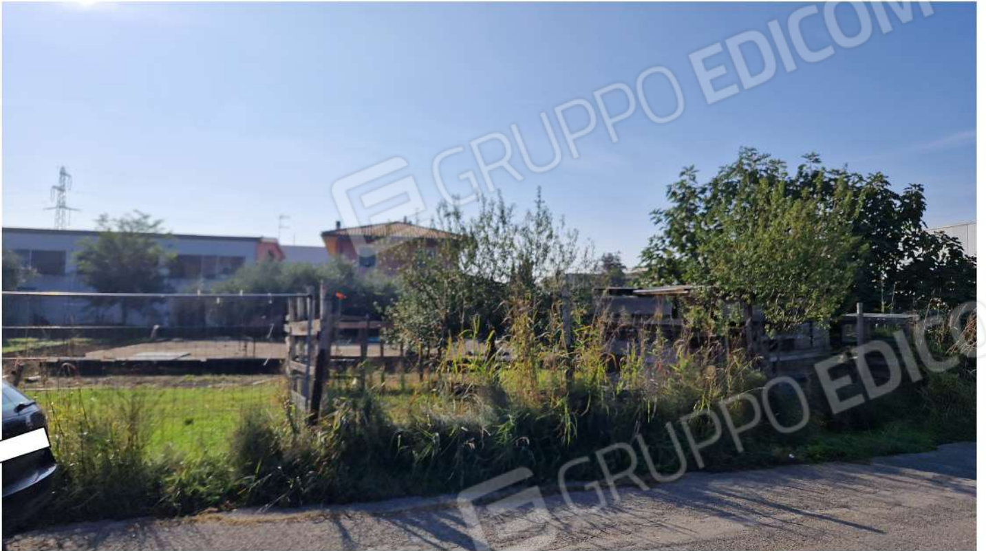
Altra vista esterna dalla Via dal Prato (lato nord)
