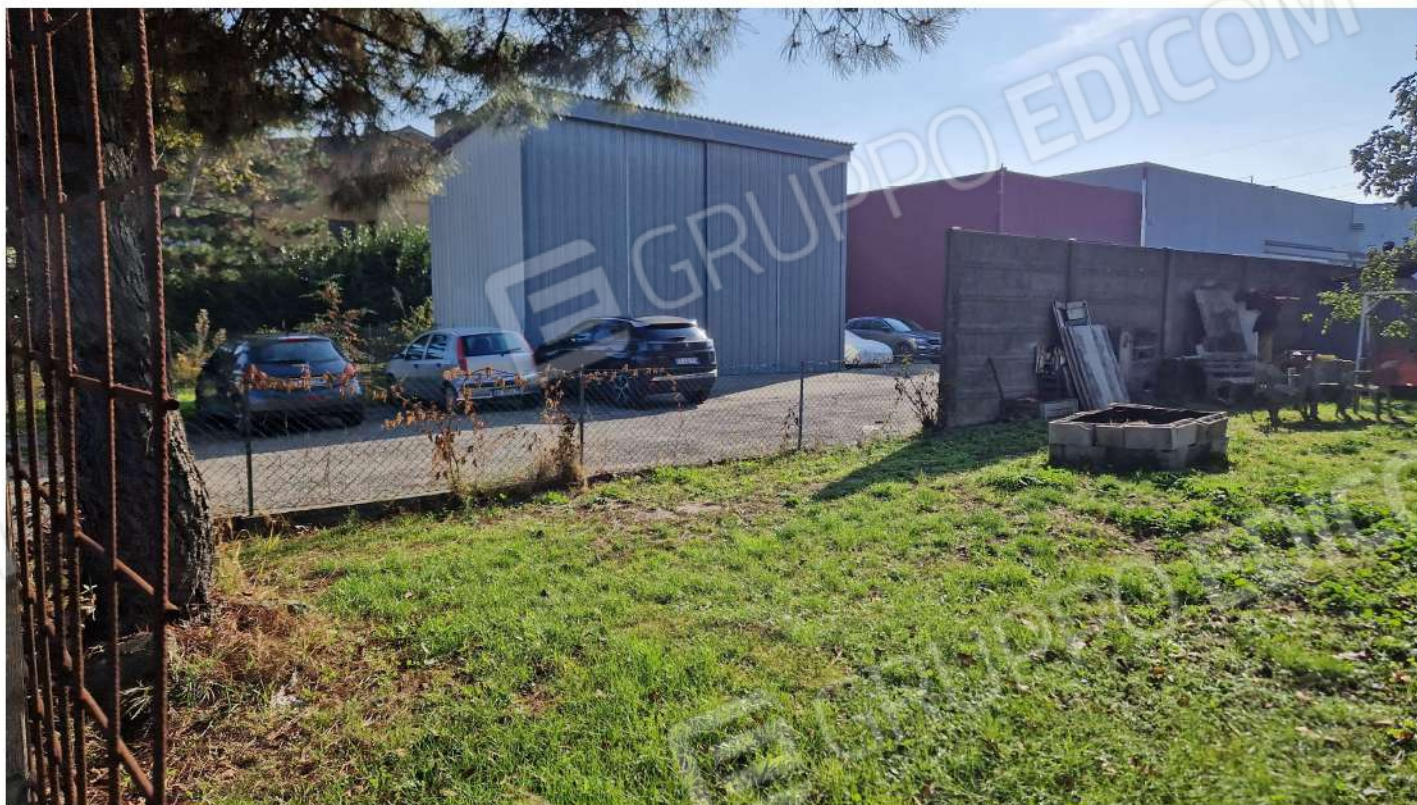
Vista interna – recinzione (lato est)
