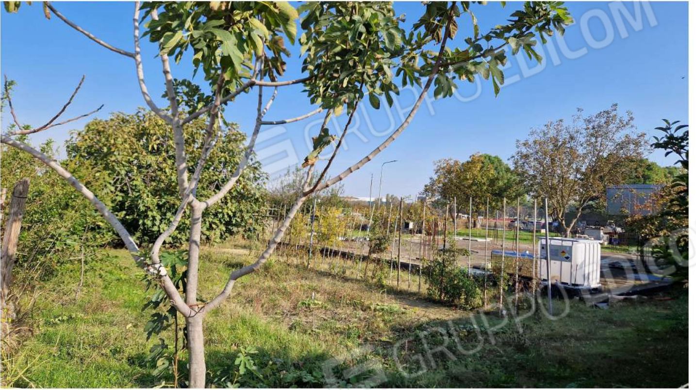
Vista interna – platea centrale in c.a. (lato ovest)
