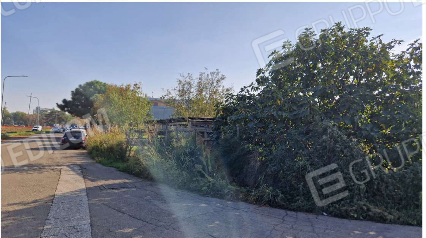
Vista esterna dalla Via dal Prato (angolo nord - ovest)
