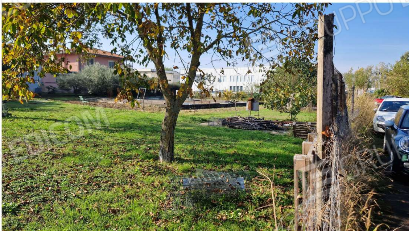
Vista interna – platea in c.a. (lato nord - est)
