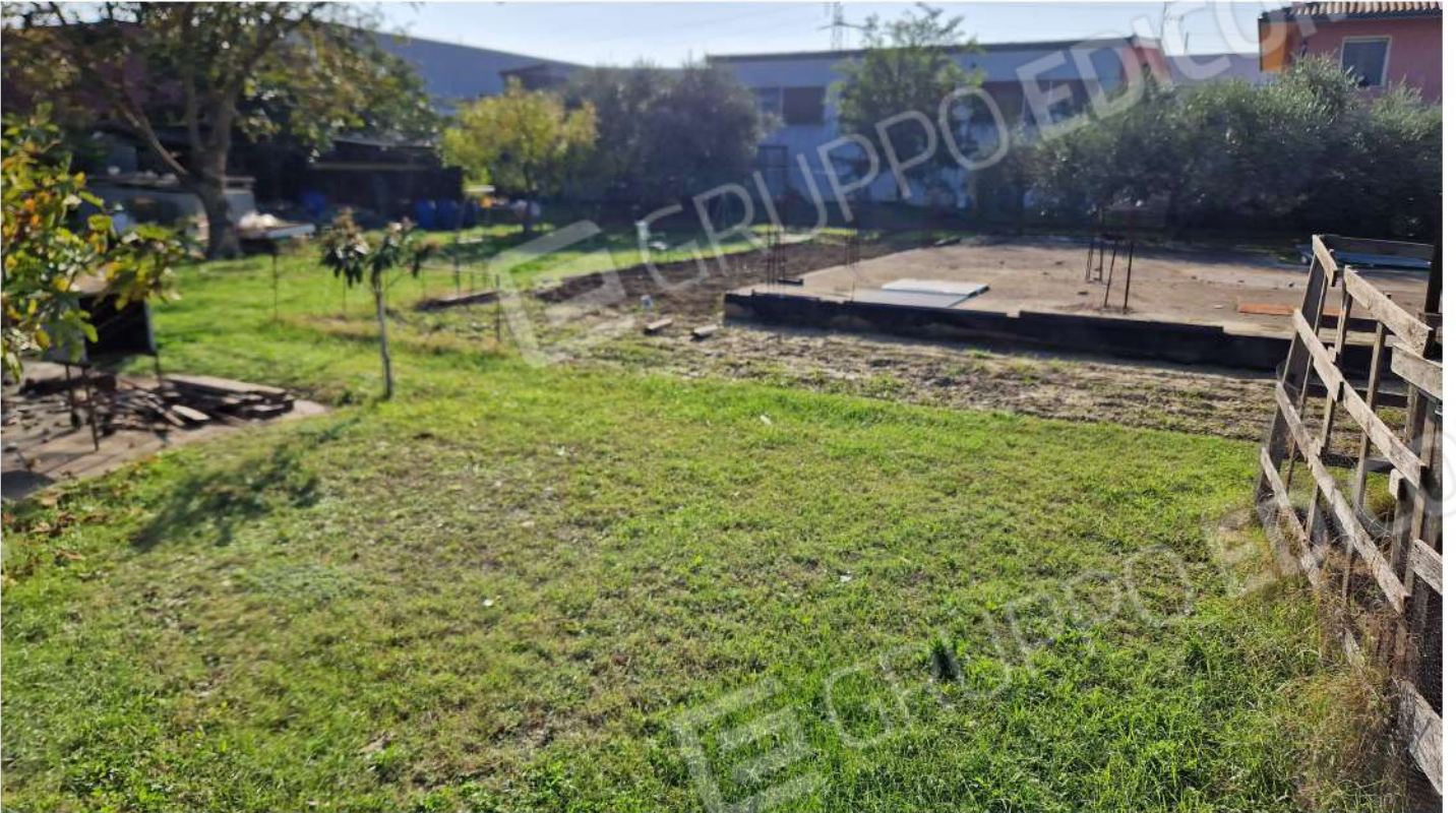
Vista interna – platea in c.a. (lato nord)
