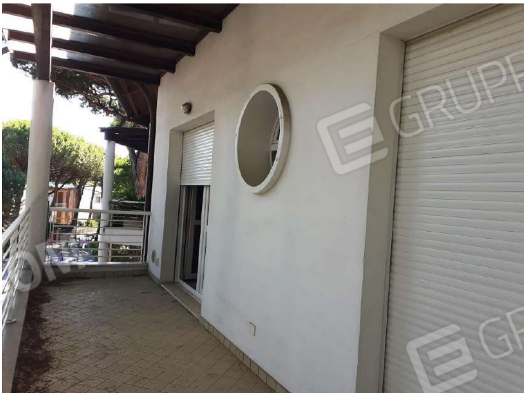
LOGGIA SOGGIORNO/CAMERA SUL LATO SUD DELL'APPARTAMENTO LATO VIALE RAVENNA
