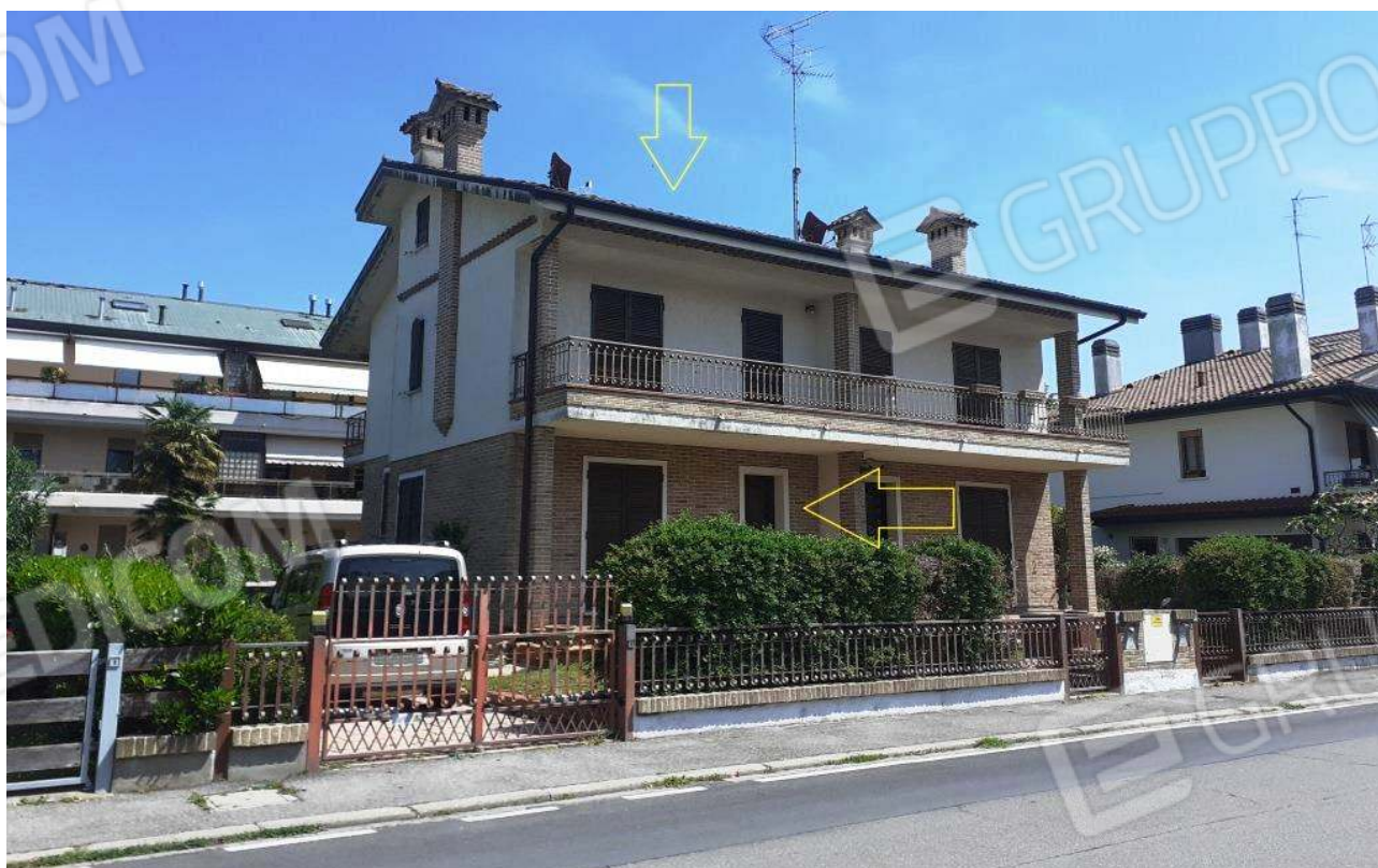
VISTA PROSPETTI NORD E OVEST SU VIA TESTI RASPONI N. 39 INDICAZIONE DELLE UNITA' SUB 1 (ABITAZIONE) E SUB 2 (GARAGE)
