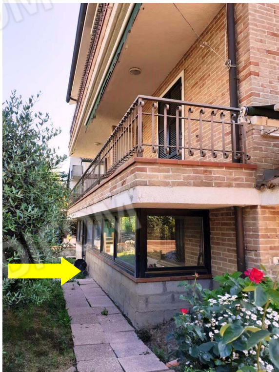
VISTA PROSPETTO EST – TAMPONAMENTO SOTTOSTANTE AL BALCONE DEL PIANO TERRA NON AUTORIZZATO E PARTICOLARE BALCONI COPERTI
